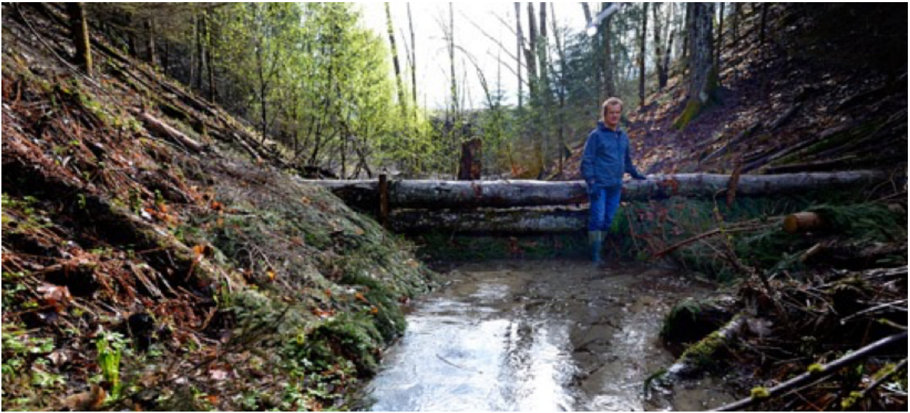
Figur 5: Bygging av kvistdam av jernbaneverket i ravinedal på Minnesund. Foto Bent Braskerud.
