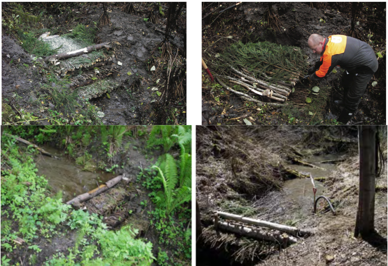
Figur 6: Bygging av kvistdam av jernbaneverket i ravinedal på Minnesund. Foto Bent Braskerud. (Kilde Braskerud & Hauge 2013).
