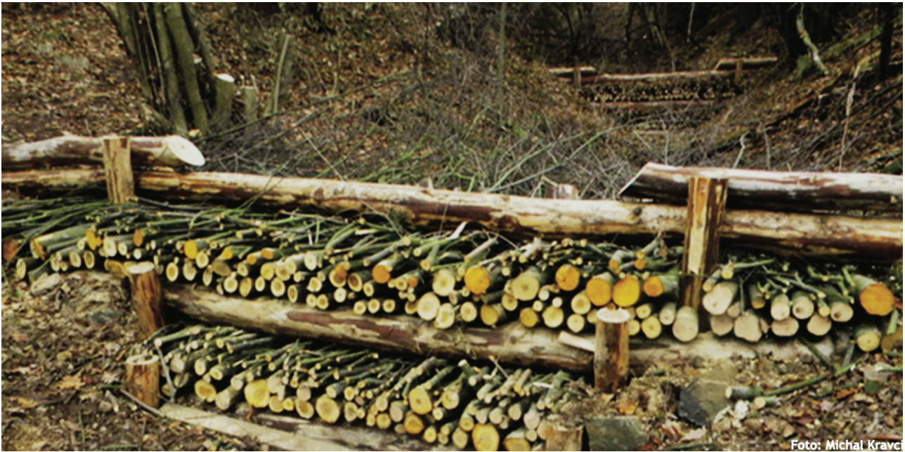
Figur 7: Slovakisk rekke av kvistdamer bygget i nedbørfeltet til Torysa elven. Foto Michael Kravcik.
