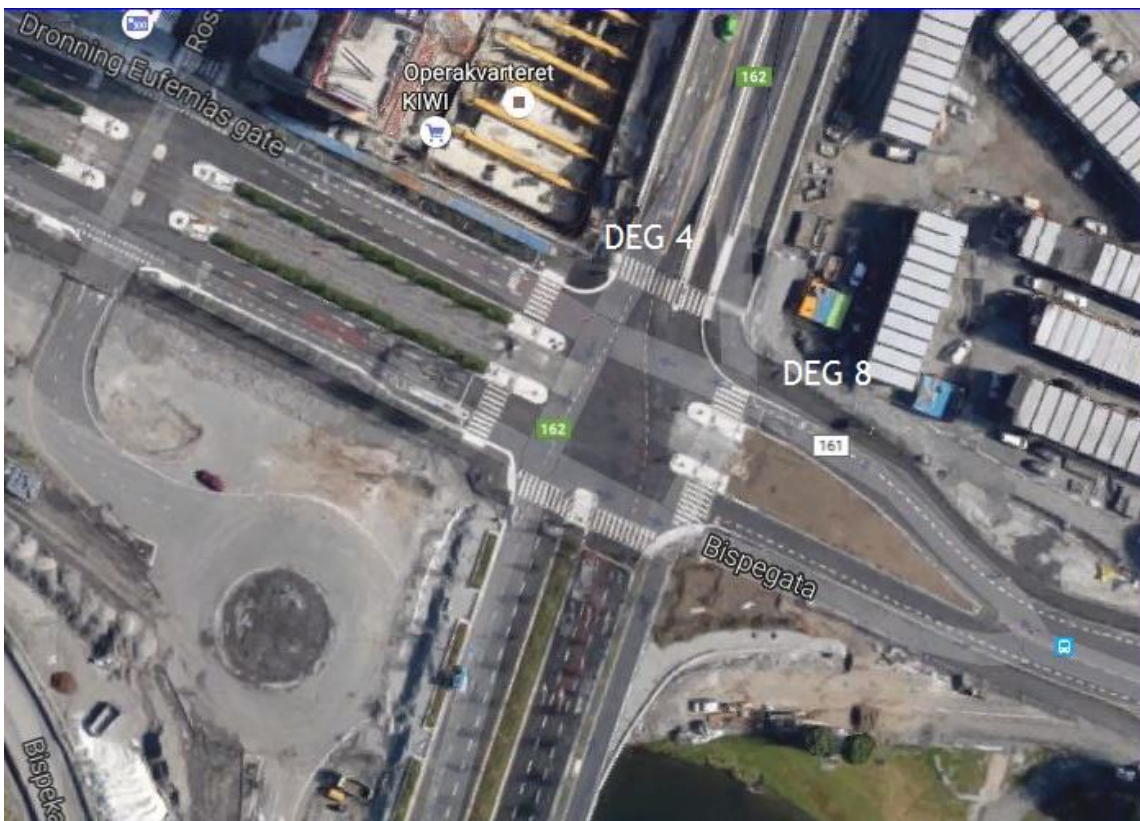
Figur 2 Oversikt over miljøbrønner ved Bispegaten, Bjørvika, Oslo. Eldre miljøbrønnene DEG 4 ved nybygg, og den nye på fortau av Bispegata DEG 8. (Foto Google Earth)
