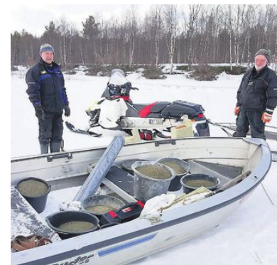
JORDE JOBBEN: Det var Egon Sotkajervi (tv.) og Bjørn Danielsen som bygde hekkeplattformen. Her klarjør de å la lass med sand som skal fylles opp i plattformen.
