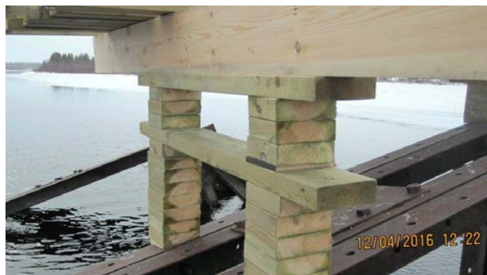
Figur 9. Bildet viser understellet festet til brukonstruksjonen. Foto: Bjørn Arnfinn Danielsen
