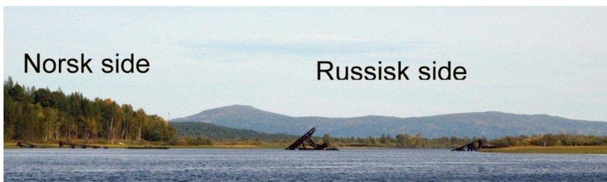
Figur 1. «Tyskerbrua» ble bygd av tyskerne i forbindelse med forsøket på å ta Murmansk by i 1942 og sprengt når de trakk seg ut i 1944. Foto: Bjørn Frantzen
