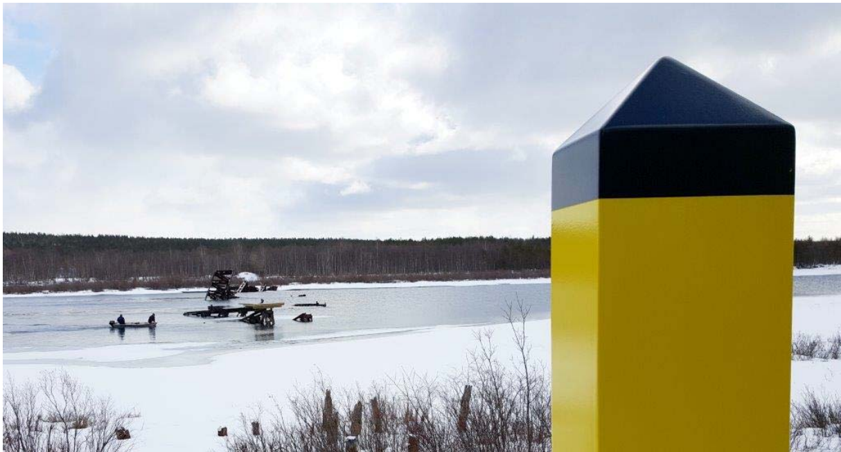
Figur 8. Bildet som er tatt fra grensemerke 25 viser båttransport til bruelementet der plattformen bygges. Foto: Arild Lyssand.
