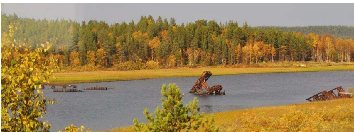
Figur 2. Den sprengte Tyskerbroa sett fra fugletårnet på russisk side. Foto: Susanne Wasa Hagen, Finnmark fylkeskommune
