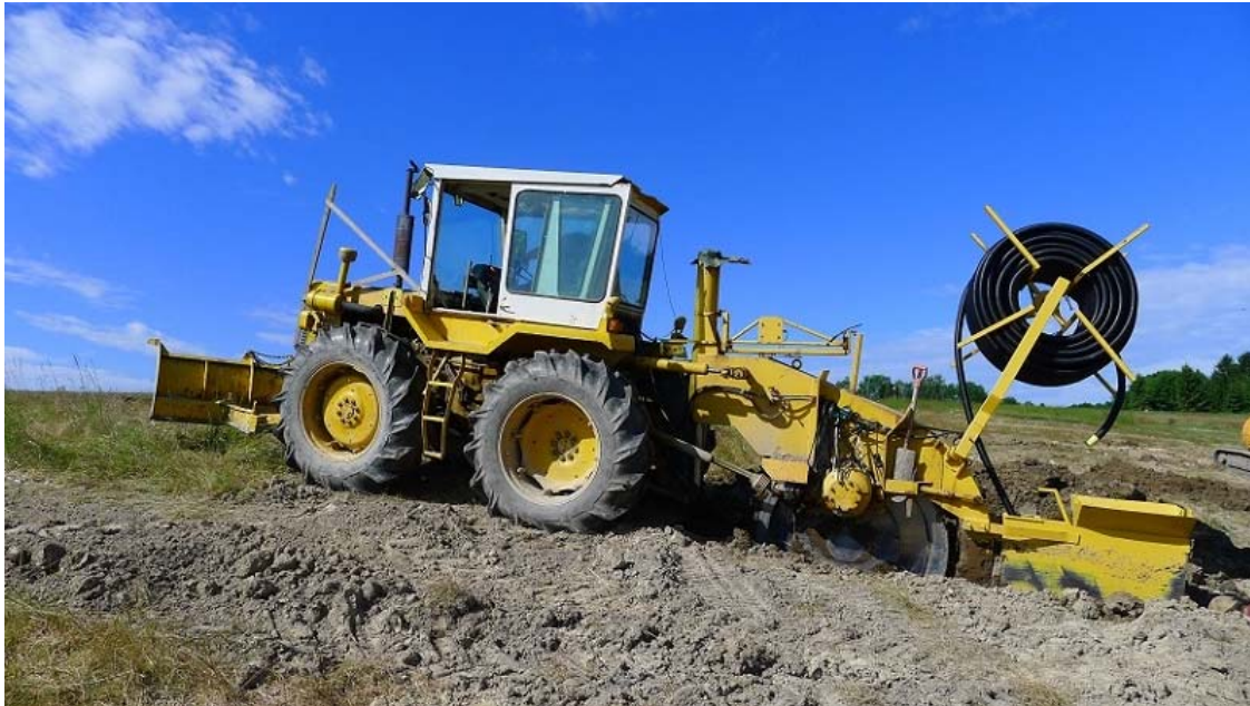
Figur 9. Hver rute ble grøftet langs fallretningen med Rådalshjul.
