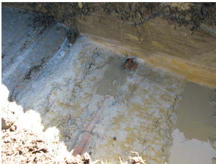
Figur 6. De gamle grøftene var av teglstein fungerte dårlig. Det var lekkasjer og mye sedimentavleiring.
