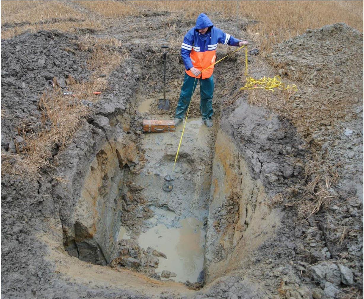
Figur 3.8 Veggene i jordprofilet (Deli 2) ble relativt fort ustabile, og etter ca 45 min hadde begge sideveggene begynt å rase inn. Sjakten ble gravd fra øst mot vest (langs fallet).
