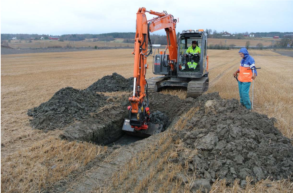
Figur 3.4 Graving av jordprofil (Deli 1) med gravemaskin, 9. april 2014. De ulike sjiktene ble lagt hver for seg for å kunne legge jordlagene tilbake i riktig rekkefølge etterpå.
