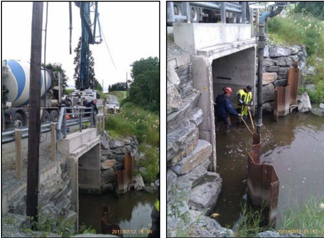
Figur 2. Tetting av lekkasjen under Crump-overløpet, juli 2011.
