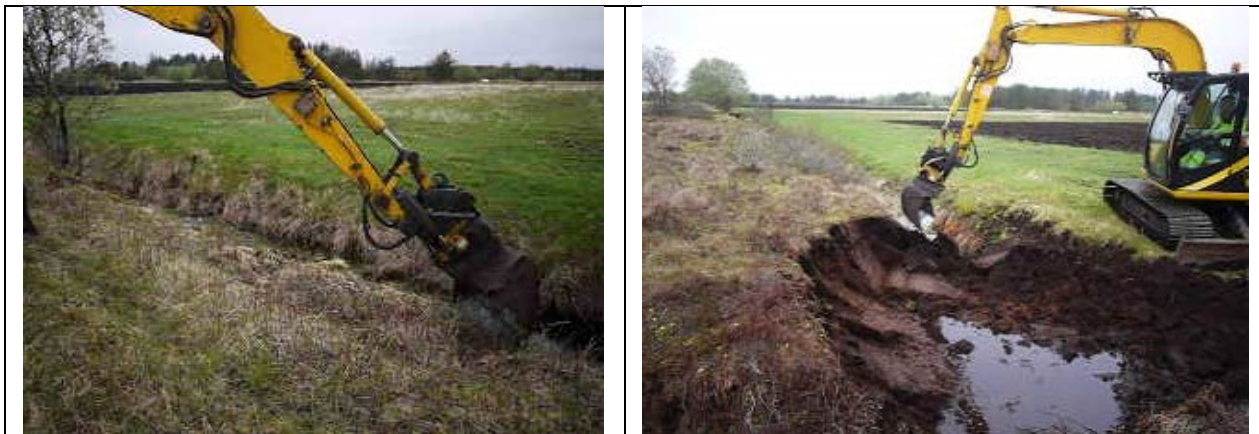
Figur 6. Gjentetting av kanal med gravemaskin.
