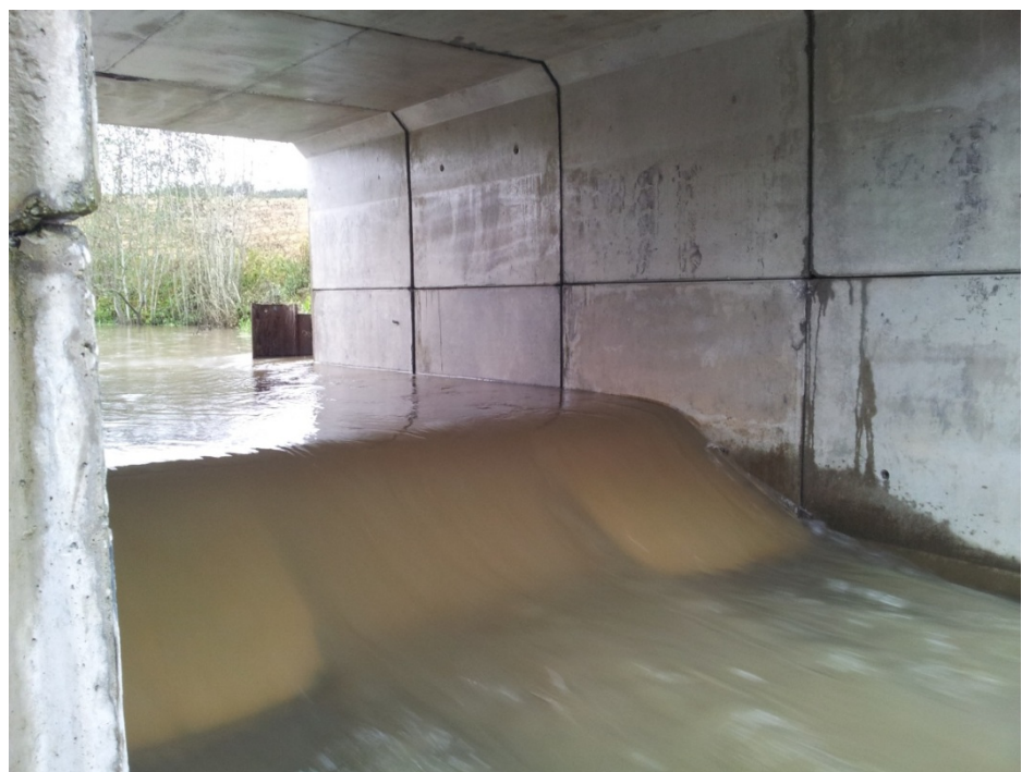
Figur 1. Vannstrømmen gjennom Crump-overløpet i Hotranelva.
