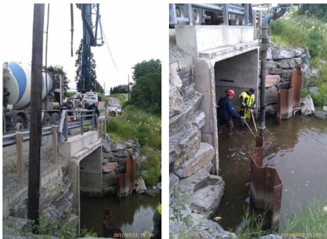
Figur 2. Tetting av lekkasjen under Crump-overløpet, juli 2011.
