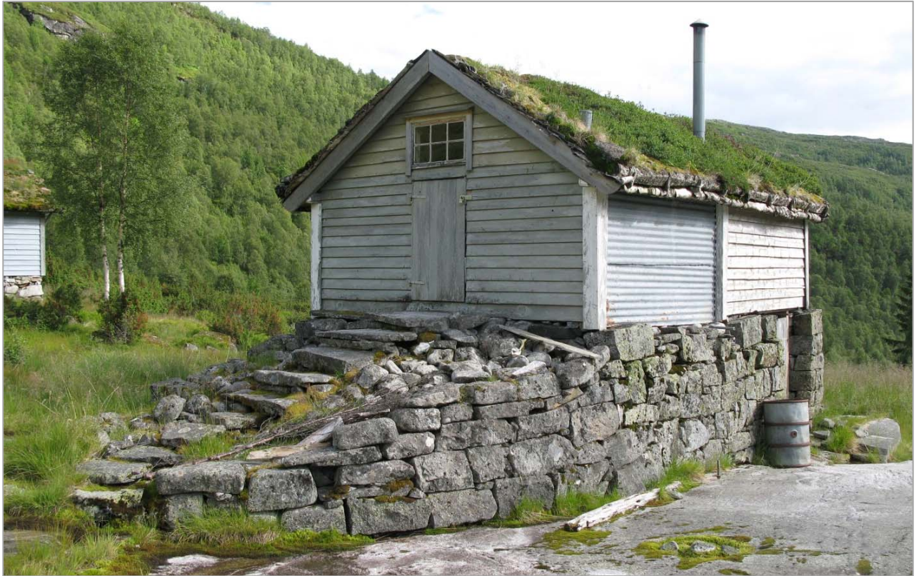
Bua med to rom, inn- og utsel, er karakteristisk for store deler av Vestlandet. Inneålet er budeias bolig, utselet for koking og oppbevaring av utstyr. Ofte er inneålet bygd i lafta tømmer mens utselet er mindre solid i reisverk eller grindverk. Selet står her på høy mur med fjøsrom i underetasjen. Det har et lite vindu over døra og et større i inneålet med sikt ut over dalen. Foto SEE, Balestrand i Sogn og Fjordane.
