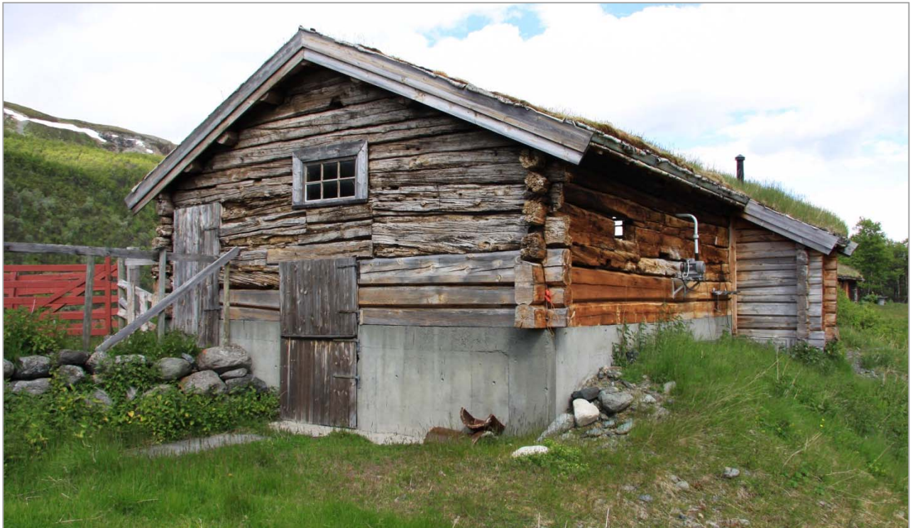
Tømmerfjøsset er løftet opp og har fått ny sokkel. Den gamle innmaten med båser er fjernet og erstattet av en mjølkegrav. Foto KAS, Oppdal i Sør-Trøndelag.
