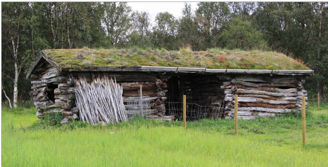
Løa skulle gi tørr, men luftig lagring. Dette fikk man ved å lafte med ujevne stokker, for eksempel av bjørk. Bildet viser ei toroms løe med skut, i Dalsbygda kalt hopløe. Foto KAS, Os i Hedmark.
