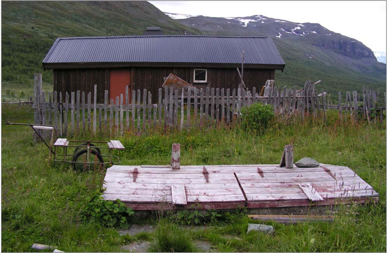
Støpt avkjølingskum dekket med lem. Bak står tralla til frakt av melkespann. Foto KAS, Vågå i Oppland.
