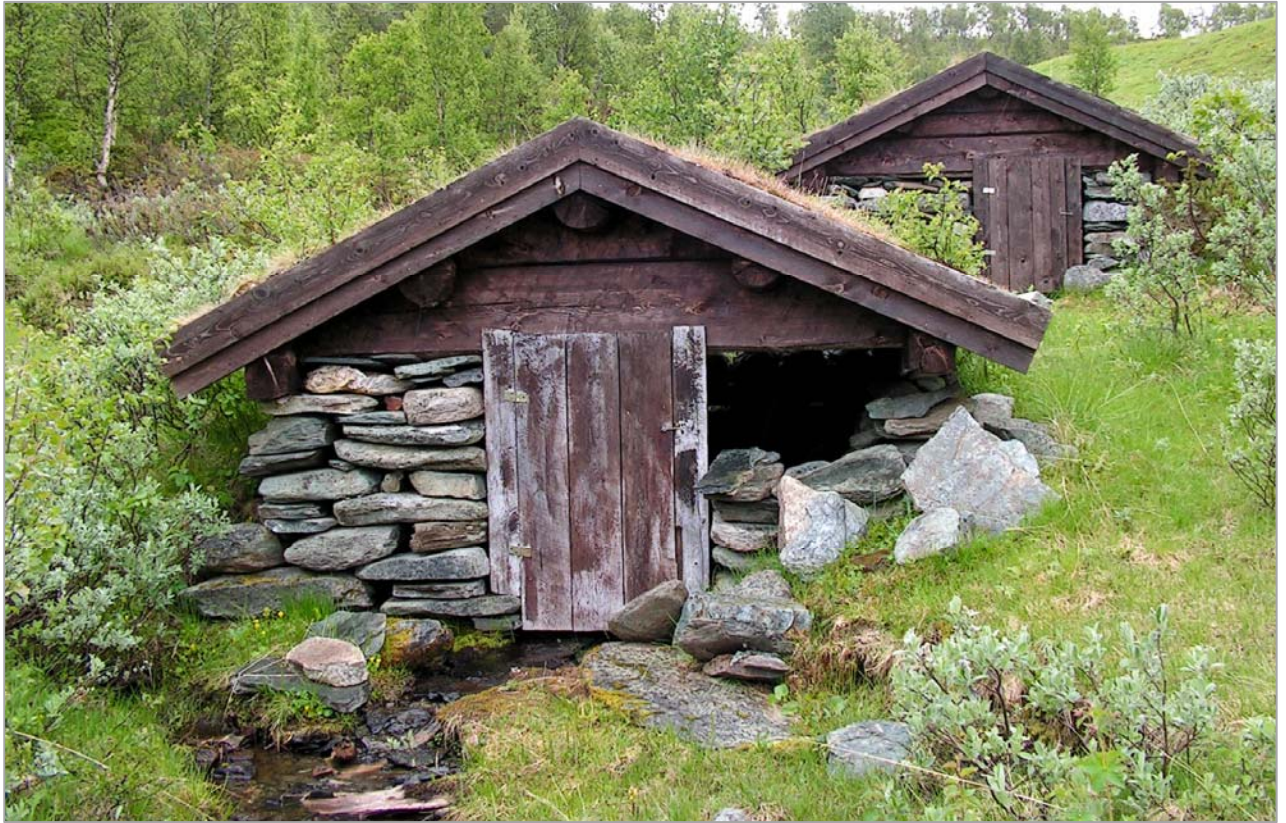
Med «koldt vannsmetoden» som ble innført på slutten av 1800-tallet, fikk vi en overgang fra tørr avkjøling av fersk melk i mjølkebua til avkjøling i rennende kaldt vann. De eldre «vasshusene» er mindre enn nyere avkjølingshus som er tilpasset melkespann. Foto SEE, Rennebu i Sør-Trøndelag.
