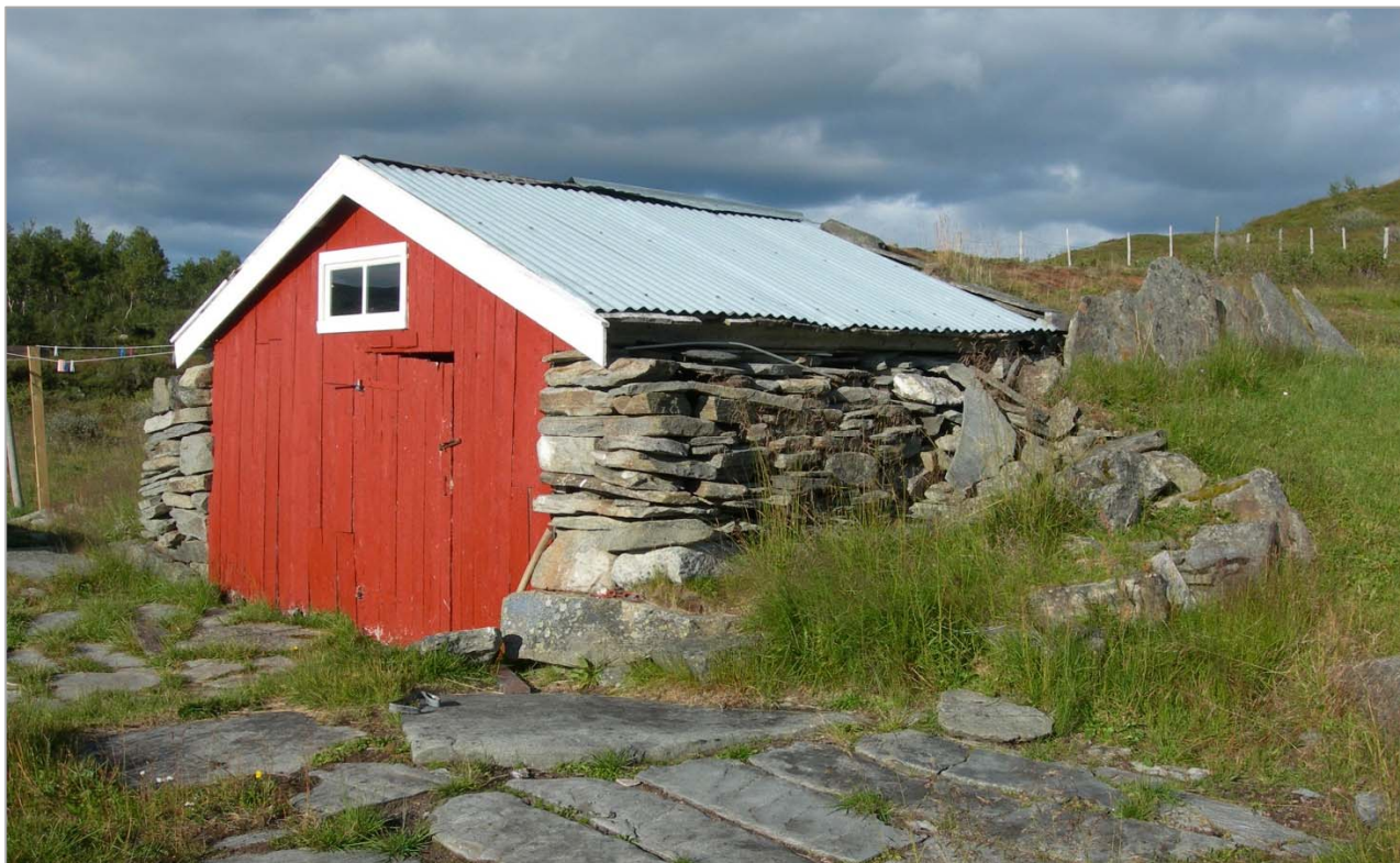
Den eldste mjølkebu er gravd godt inn i bakken og kledd med torvtak og steinheller. Det nyere tilbygget foran bua har steinsatt vegg og bølgeblikktak. Foto KJM, Holtålen i Sør-Trøndelag.
