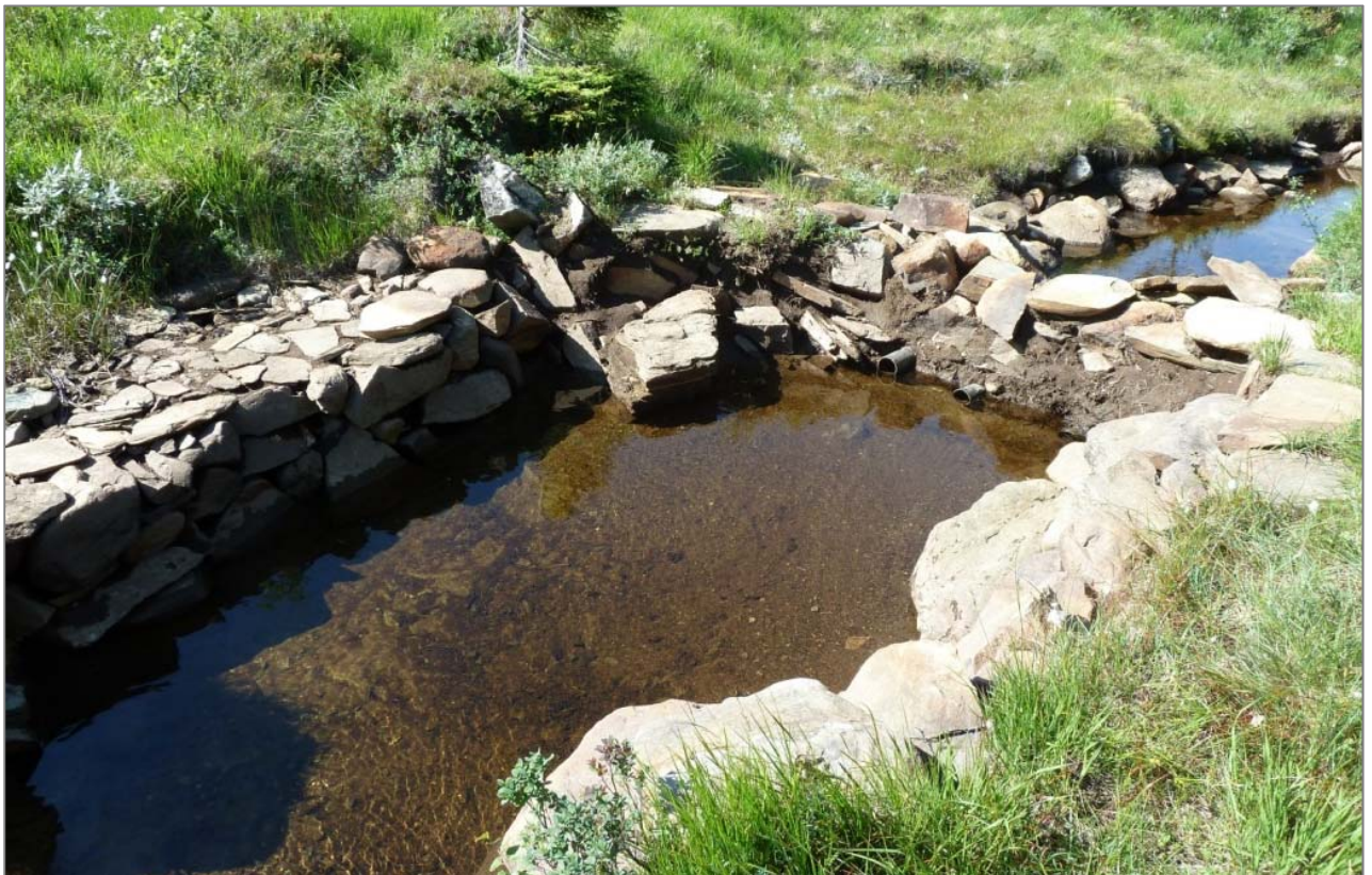
Steinsatt avkjølingsplass for melkespann i bekken. Foto WEF, Tydal i Sør-Trøndelag.
