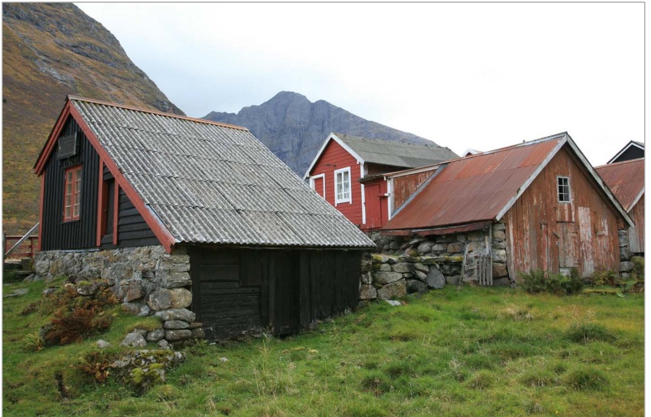
To seterhus med sel og fjøs sammenbygd slik at fjøset ligger i muren under, men ved siden av selet. Foto OSP, Ørsta, Møre og Romsdal.
