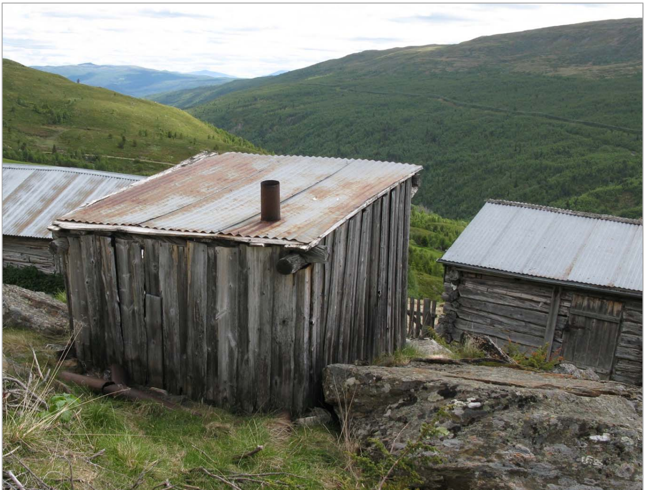
Kokkuset er bygd i en konstruksjon som minner om stavlaft eller grovt bindingsverk. Huset har stolper i hjørnene, ett lafteomfar i bunnen og ett i toppen, og ytre bordkledning. I vårt system blir det forenklet og upresist registrert som reisverk med stående panel. Foto SEE, Vågå i Oppland.
