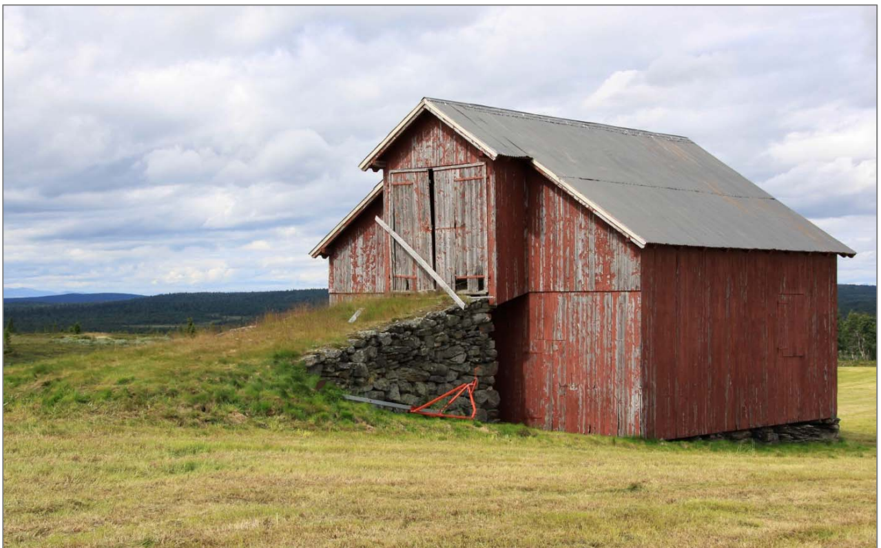
Bare fem prosent av løene på setrene er rødmalte. Bordkledd reisverk overtok for tømmer i løer på Østlandet utover 1900-tallet. Foto KAS, Ringebu i Oppland. Foto KAS.
