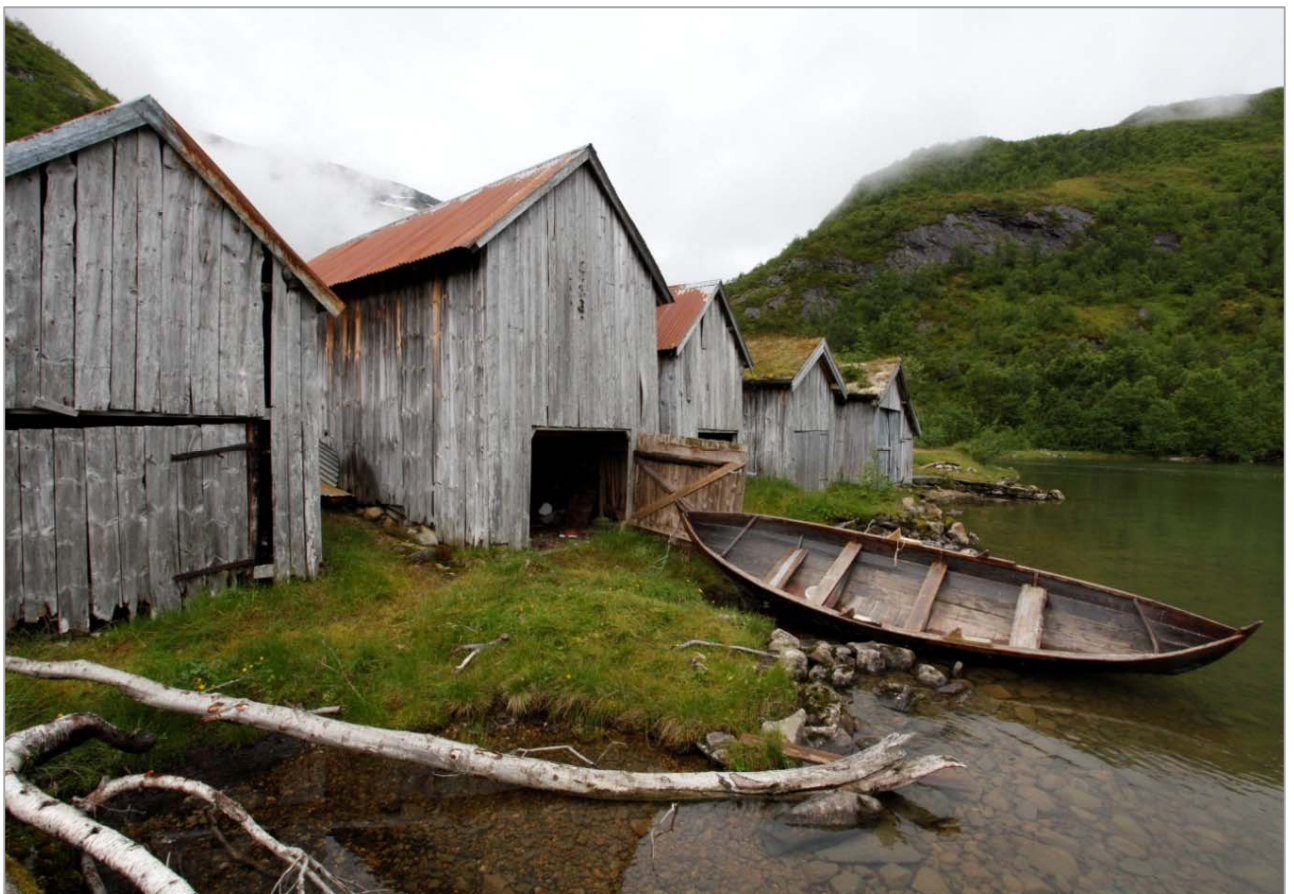
Naust kombinert med løe. På Herdalssetra ble seterhøyet rodd over vannet og plassert i et høyrom over båtnauset. Der ble det henta og kjørt til gards med hest på vinterføre. Foto OSP, Nordal i Møre og Romsdal.
