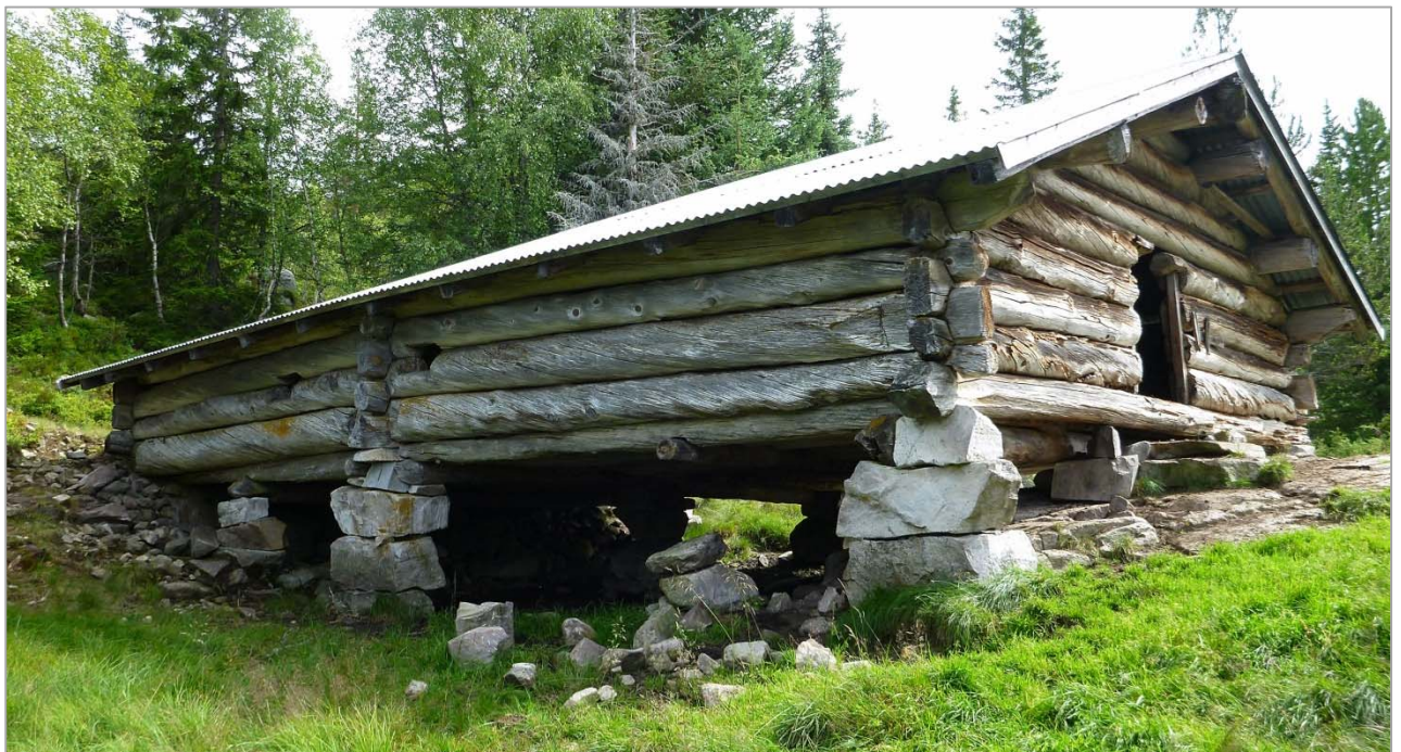
Med grovt og solid tømmer skulle det ikke så mange stokkene til. Foto FRB, Tinn i Telemark.
