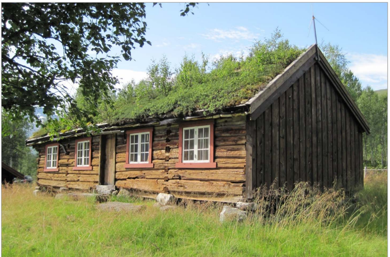
I dette selet kan man kjenne igjen den langstrakte og smale låna med gjennomgående rom, der eventuelle påbygg kom i lengderetningen. Foto SEE, Surnadal i Møre og Romsdal.
