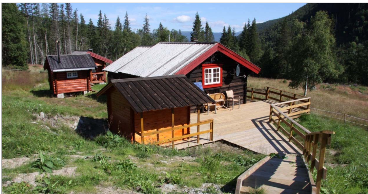
Alle setereiere er ikke like opptatt av bevaring. Når anlegg utvides med nye hus for fritidsbruk, og seterstua bygges på mens uthusene blir borte, forsvinner «setra» inn i et hyttetun. Det trengs tiltak for å bevare tradisjonelle seterbygninger og seteranlegg som fortsatt har noenlunde «komplette» bygningsmiljøer. Foto KAS.
