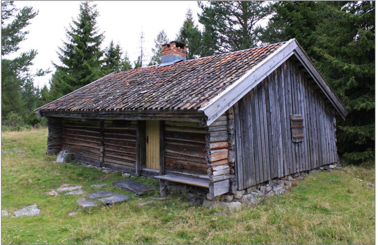
Det er sparsomt med vinduer i den gamle seterstua på Totenåsen. Budeias oppholdsrom har bare et lite vindu på gavlveggen og en glugge på langveggen. Denne setra har teglsteinstak både på stue og fjøs og er restaurert nokså nylig. Foto KAS, Østre Toten i Oppland.
