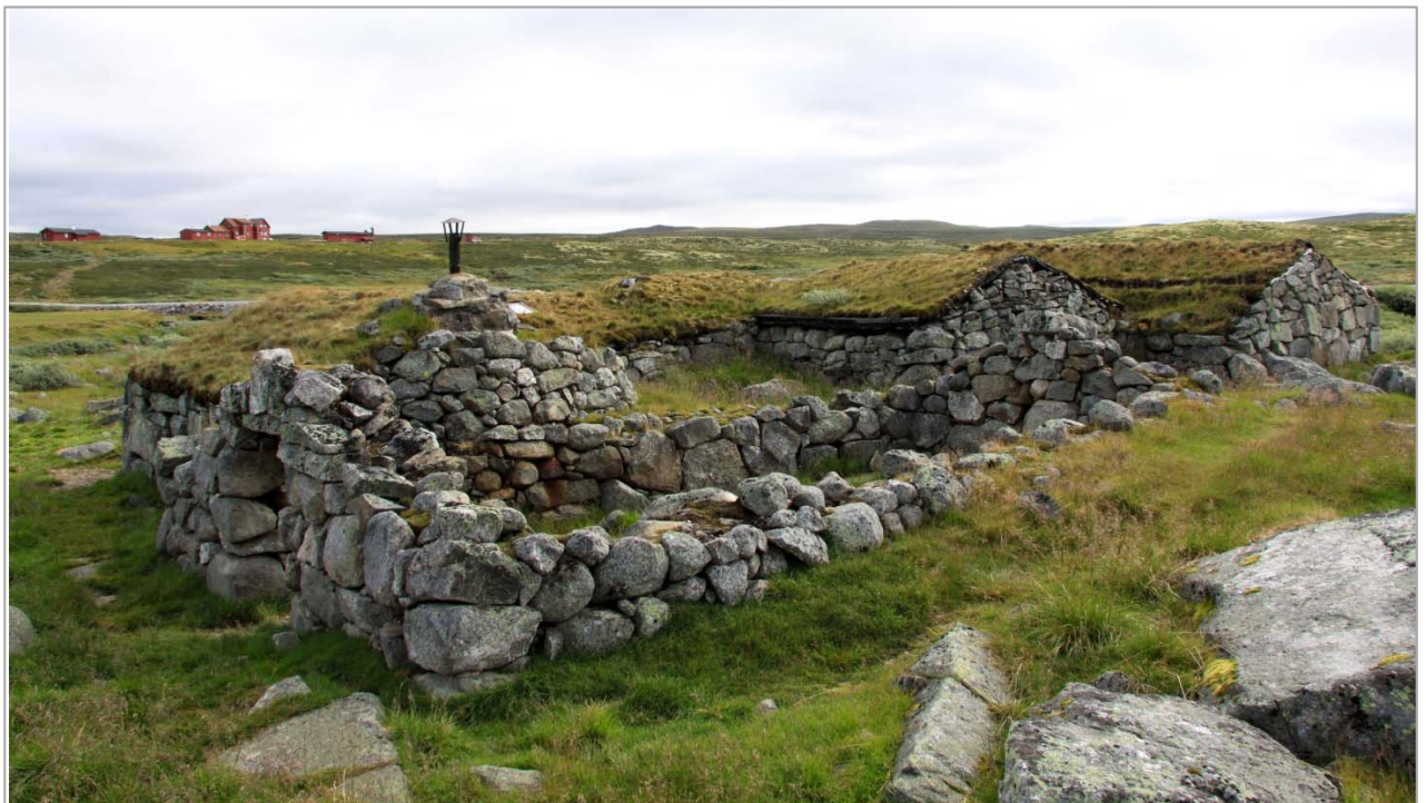
På Hardangervidda har det vært omfattende aktivitet med jakt og ferdsel, fedrifting og støling. På østvidda er stølshusene stort sett i lafta tømmer, på vestvidda er mye bygd i stein. Agastølen i Bjoreidalen består av fem sammenbygde steinbuer. Trolig var dette støl for to bruk. Her er to sel og to kokhus (her kalt skut), et fjøs uten tak nærmest på bildet, og en innhegning midt i anlegget. Foto KAS, Eidfjord i Hordaland.
