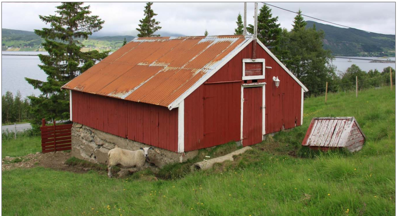
Det er størst andel rødmalte fjøs i de nordlige landsdeler. Foto KAS, Kvæfjord i Troms.
