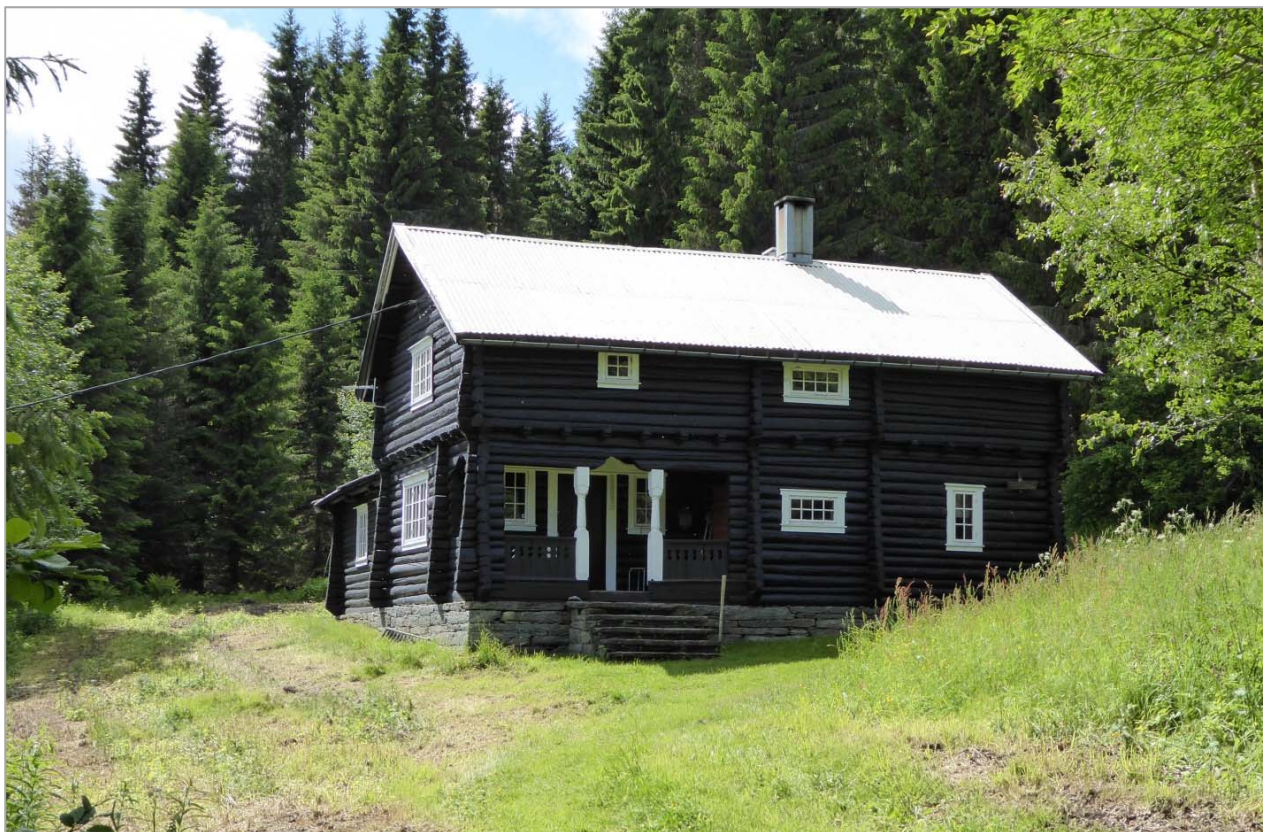
Skihytta til Steinkjer skiklubb har stått på tidligere Fossemsetra på Byafjellet siden 1920. Foto KAS, Steinkjer i Nord-Trøndelag.
