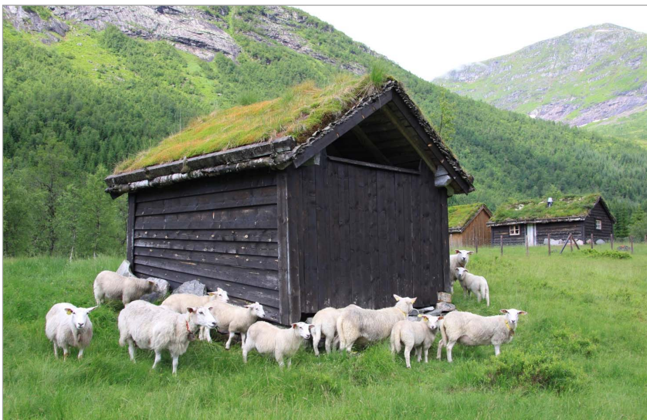
Åpning i gavlen, åpen gauk, har vært vanlig på små løer på Vestlandet. Foto KAS, Førde i Sogn og Fjordane.
