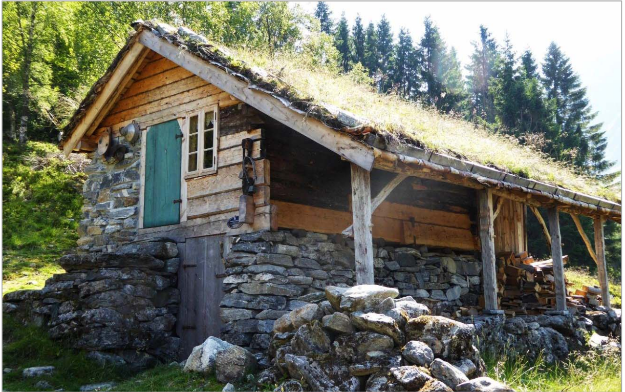
Nakkeselet på Brunstadsetra er bygd opp igjen fra det totale forfall. Det uvanlig skikkelige restaureringsarbeidet ble belønnet med bygningsvernpris fra Fortidsminneforeningen. Foto KAS, Sykkylven i Møre og Romsdal.
