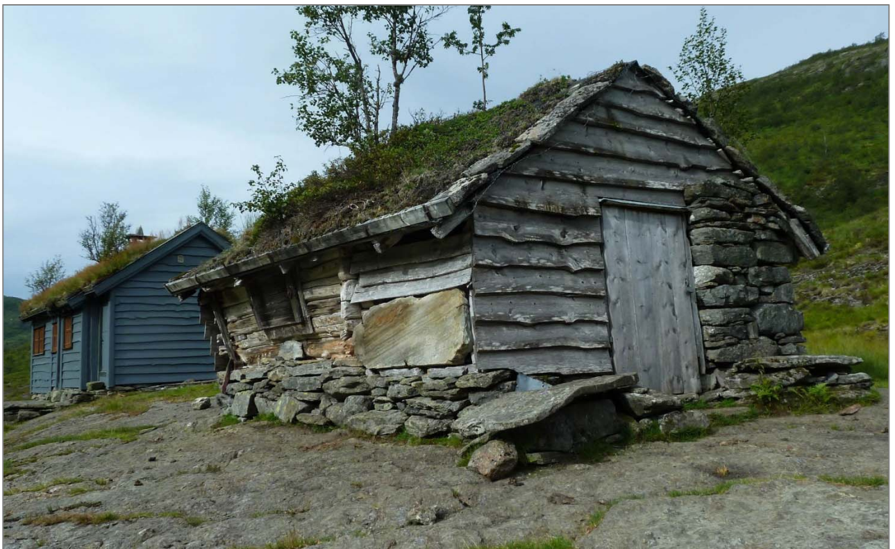
Gammelt toroms sel i Kvam i Hordaland. Tømmer i små dimensjoner, beskyttet med panel og steinheller i de mest værutsatte eller slitte partiene. Foto WEF.
