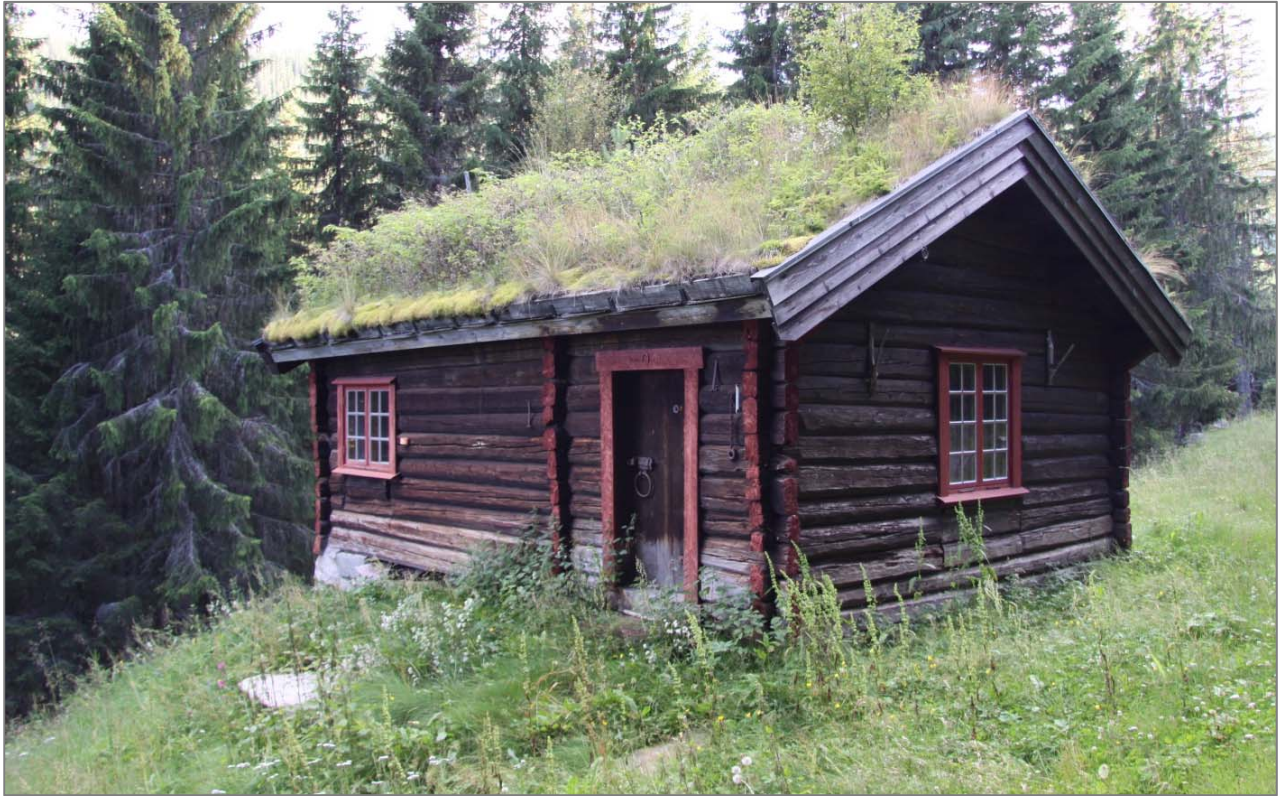
Stue på seter i Telemark med rominndeling etter tradisjoner fra middelalderen. En såkalt treromsstue med inngang på langveggen inn til en forstue eller gang og dør derfra inn til stua. Foto KAS, Tinn.
