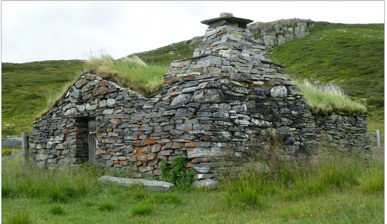
I fjellområdene er det brukt en god del stein i seterbygningene, men hovedsakelig i uthus. I øvre Hallingdal finner vi stein også i innhus, i form av steinbuer med karakteristiske store skorsteiner. Veggene er doble steinmurer med et jord/torvlag som isolasjon mellom. Grua er eneste lyskilde. Ofte er det delt av et mindre rom til lagerplass, mjølkebu, med en trevegg. Det er lite lys og lyd som kommer inn i steinbua når døra er stengt. Foto KAS, Ål i Buskerud.
