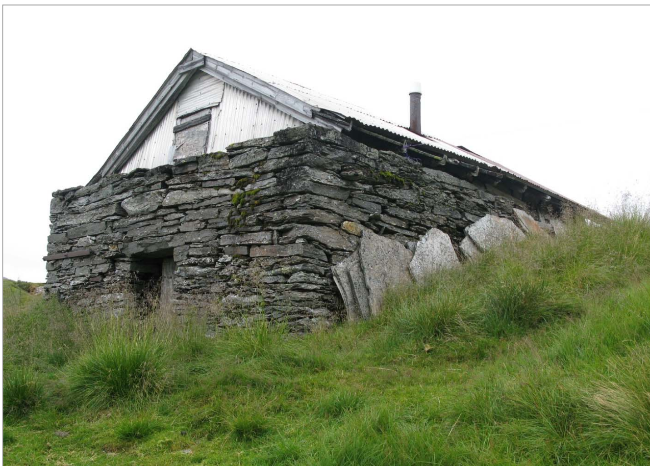
Stølsbu med fjøsrom under boligdelen er en vestlandsk spesialitet. Mange av disse fjøsene var trange og rå og ble brukt i liten grad. Foto SEE, Vik i Sogn og Fjordane.
