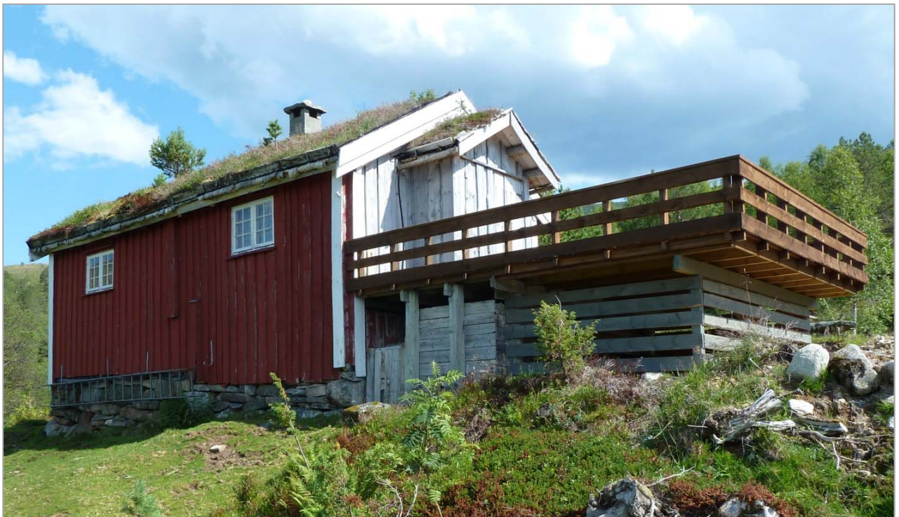
Platting med rekkverk som tilbygg på gammelt sel. En bygningsendring som endrer husets preg mye og som veiledere om istandsetting av seterhus anbefaler at man unngår. Foto JRE, Møre og Romsdal.
