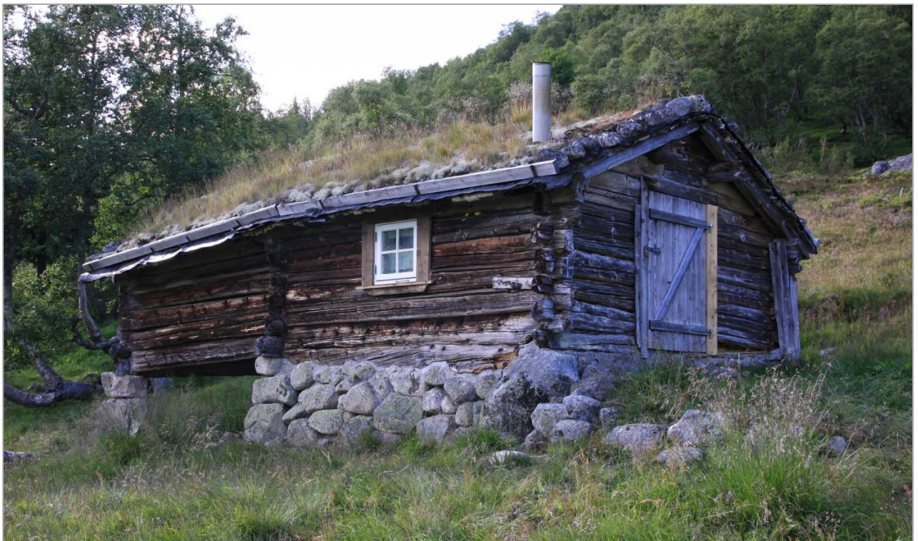
I områder der slåttene var en vesentlig del av setringa og det var vanlig å flytte mellom flere setre, måtte bygningene bli enkle. Dette selet består av to rom; bu og løe. Foto KAS, Valle i Aust-Agder.
