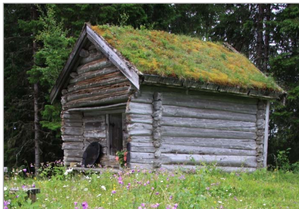
I dette området fortelles det at folk i urolige tider oppbevarte verdisaker i hus i utmarka. Som i dette stabburet. Faren lå i angrep fra svenske soldater. Foto OSP, Snåsa i Nord-Trøndelag.
