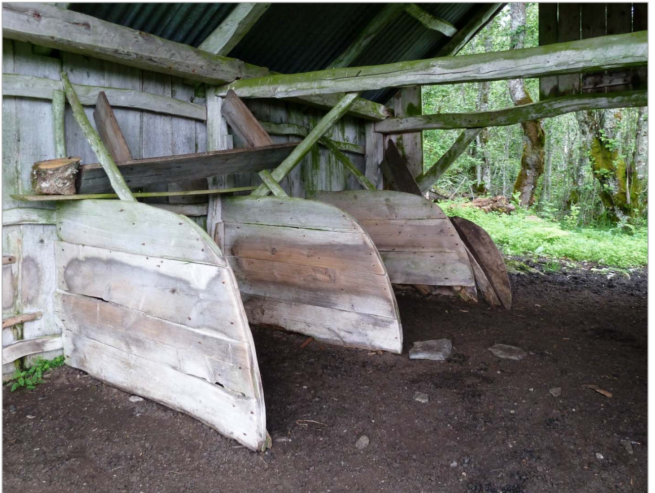
Deler av veggen fjernet og det gamle fjøset er blitt en lun plass for sau og andre forbipasserende. Foto KAS, Stryn i Sogn og Fjordane.
