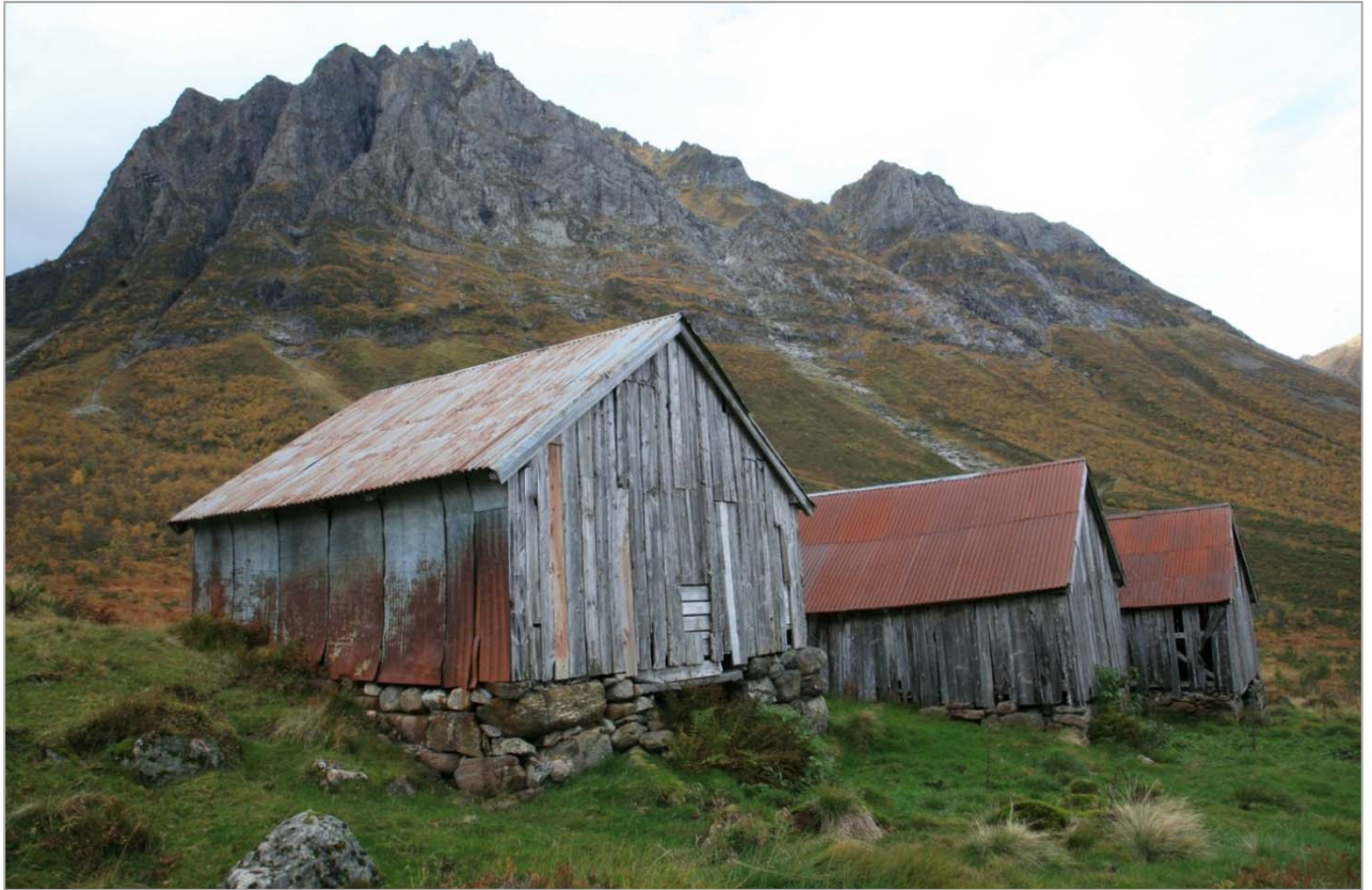
27 prosent av stølsfjøsene på Vestlandet er bygd i grindverk. Foto OSP, Ørsta i Møre og Romsdal.
