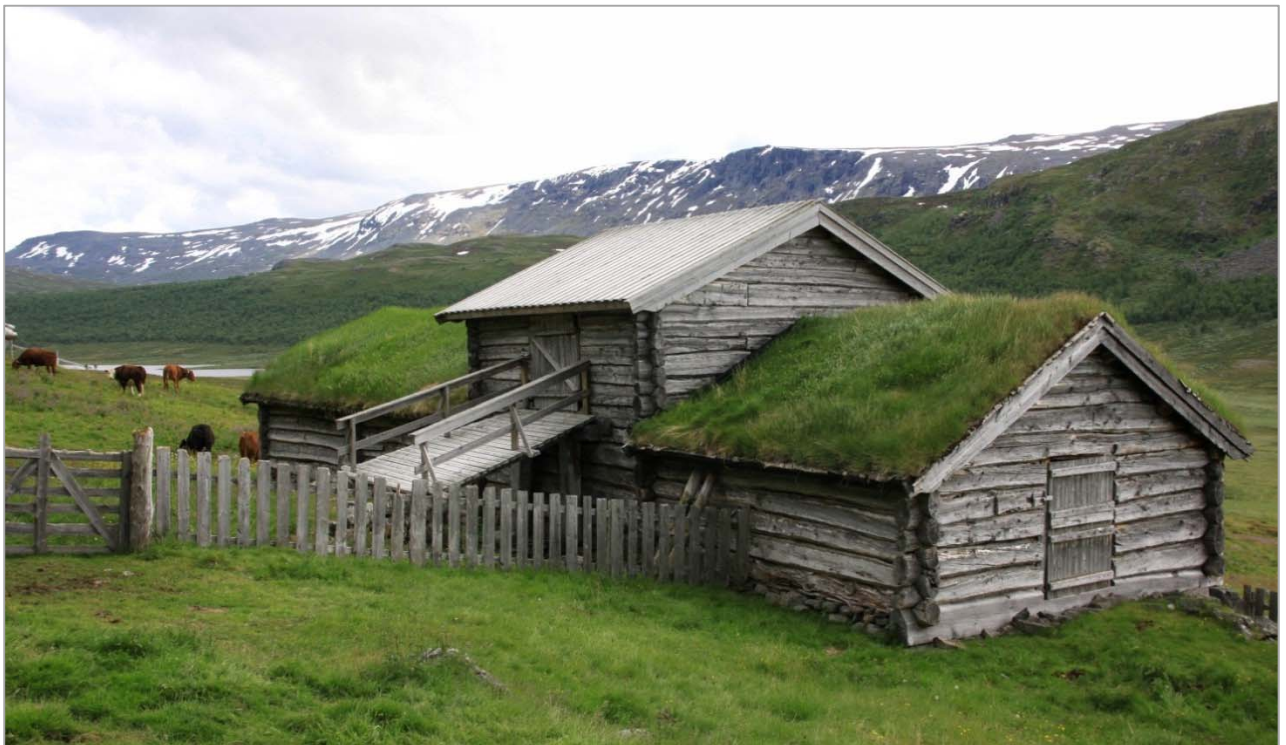
På vintersetrene i Sjudalen ble det fôret med reinlav eller måså og mange fjøs har en karakteristisk konstruksjon med tre lafta rom med måsåtrev over den midtre delen. Laven ble samlet i marka på høsten før folk og buskap reiste hjem, og hentet fram til setra under vinteroppholdet. Den ble kjørt inn på låvebrua og tint på trevet før den ble sluppet ned til dyra. Det var de store gårdene som drev vintersetring, og både fjøs og andre bygninger på disse setrene er store og solide. Foto KAS, Vågå i Oppland.
