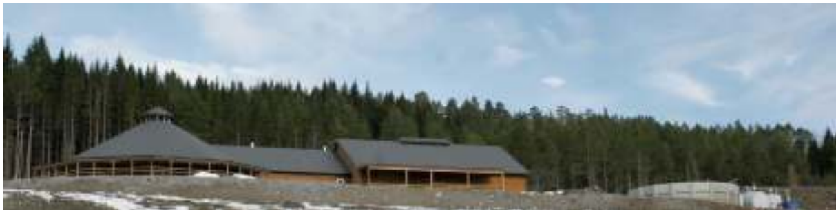
Figur 1. Til venstre: Ny driftsbygning for økologisk melkeproduksjon på Tingvoll gard, bygd i 2010. Til høyre: Sluttlager for blautgjødsel. Lengst til høyre: Råtnetank og kjøletank for biogassanlegget før dette ble bygget inn, samt teknisk kontainer med faklingstårn (blå). Foto: Anita Land.
