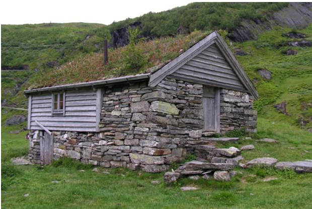
Sel med fjøs i underetasjen. To rom oppe; utsal i stein, innsel i panelt laft. Kvassdalen i Voss. Kode SOF.
