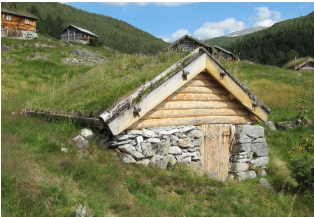
Mjølkebu. For kjølig og tørr lagring. Ofte bygd i stein og inn i bakke. Kode MBU. Nyrestaurert utgave i Luster.
