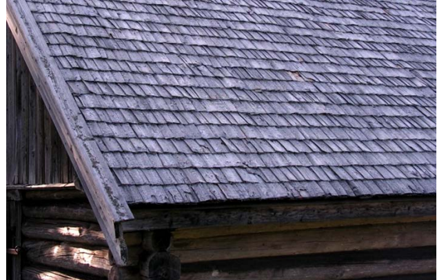
Flistak. Kode 5. Tekking med trespon og bord har hatt stor utbredelse, særlig på uthus. Romeriksåsene.
