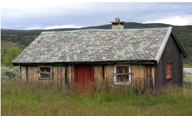
Skifertak på gammel seterstue i Valdres. Kode 3. Kalt dråpeskifer. Skifertekking var i utgangspunktet knytta til distrikt med skiferbrudd.
