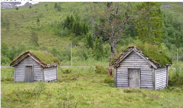
To avkjølingshus i bekk, med plass til melkespann. Stavkonstruksjon. På Myklebustsetra i Ørsta. Kode VAS.
