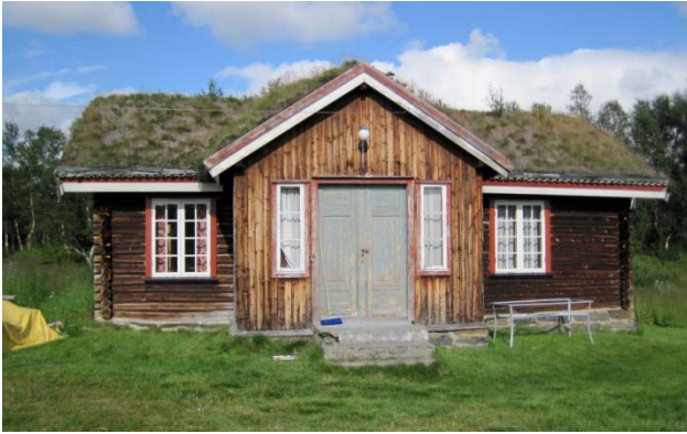
Nevertak med dekke av torv. I dag byttes gjerne neveren ut med plast. Kode 1. Tynset. Foto Sebastian Eiter.
