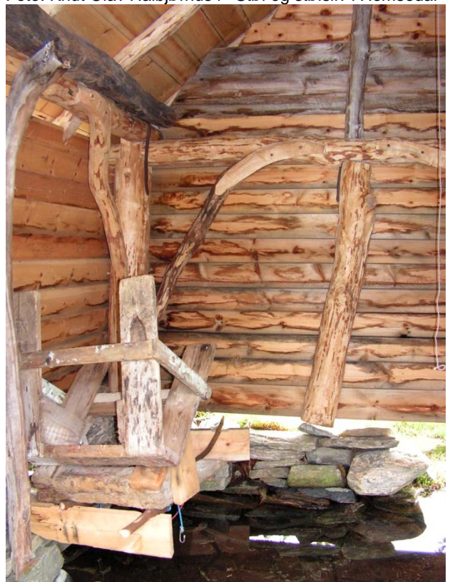
To avkjølingshus i bekk, med plass til melkespann. Stavkonstruksjon. På Myklebustsetra i Ørsta. Kode VAS.
