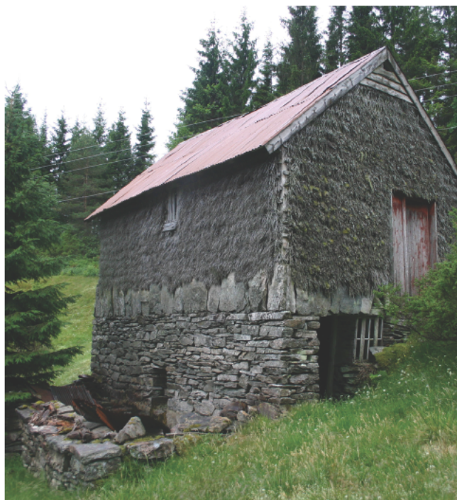
Kombinert løe og sommerfjøs. Tradisjonen med å kle veggene på uthus med brake eller einer er spesiell for Osterøya i Hordaland. Veggene blir tette, men samtidig luftige. Løa er bygd i grindkonstruksjon, som er en byggeskikk vi i dag finner bare på Vestlandet. Foto F. Bentzen.
