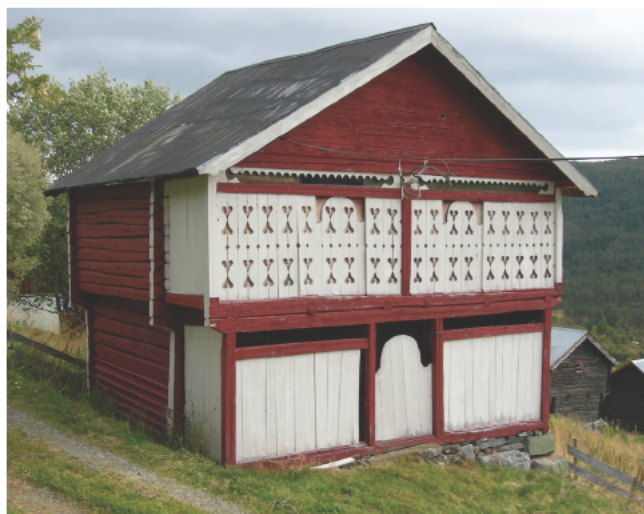
Stabburet er fortsatt tunets pryd og holdes i god stand, selv om oppgavene for lengst er overlatt til fryseboksen og klesskapet. Andre førindustrielle bygningstyper står det dårligere til med. Spesielt utsatt er bygninger som ligger utenfor tunet. Ål, Buskerud. Foto W. Fjellstad.
