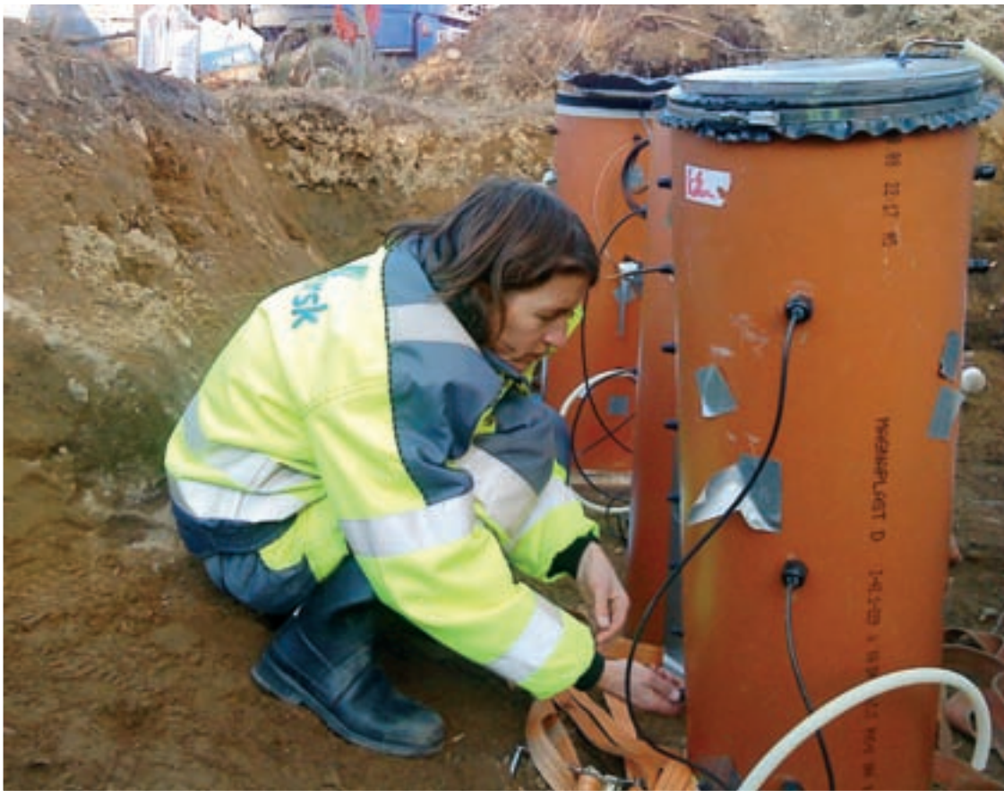
Installasjon av lysimeter for å måle avrenning frå Oslo Lufthamn Gardermoen.
