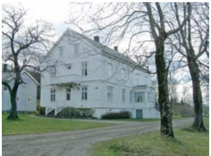
Fasade nordvest Foto: Håkon Skarstad
