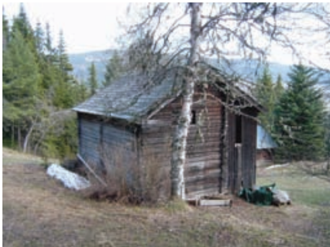
Fasade nordvest Foto: Håkon Skarstad
