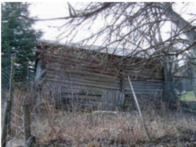
Fasade aust Foto: Håkon Skarstad
