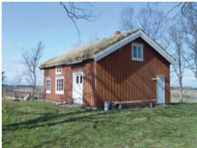
Fasade aust Foto: Håkon Skarstad
