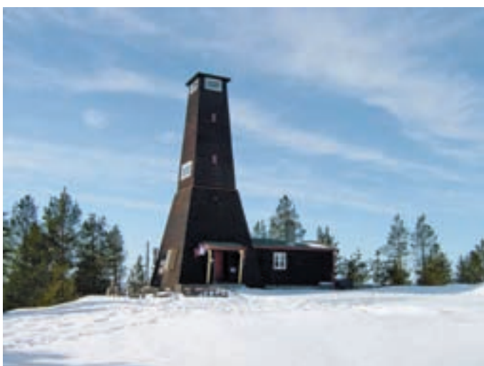
Fasade nord Foto: Håkon Skarstad
