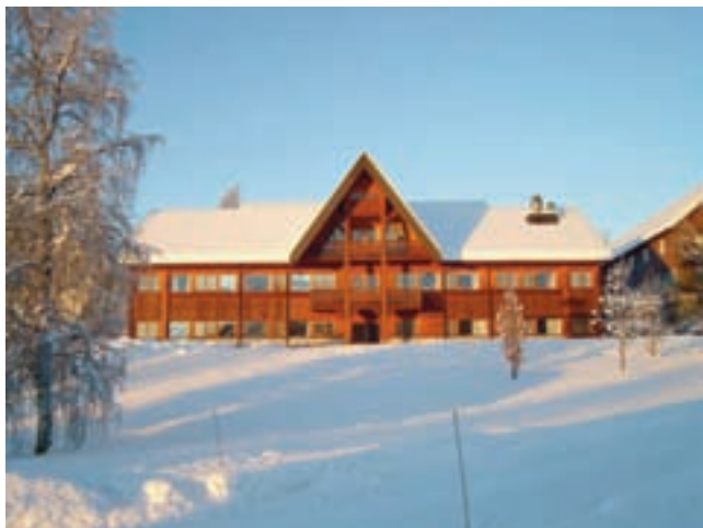
Administrasjonsbygning øst Foto: Håkon Skarstad
