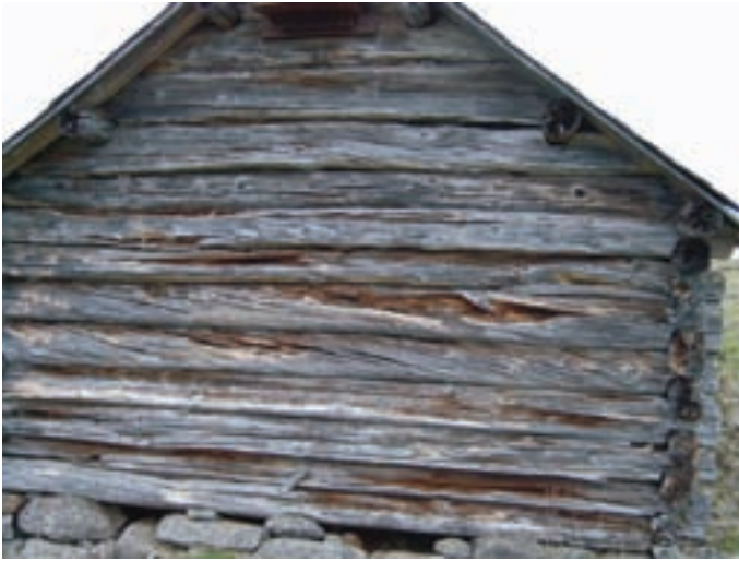
Fasade aust Foto: Håkon Skarstad
