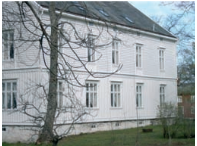
Fasade aust Foto: Håkon Skarstad
