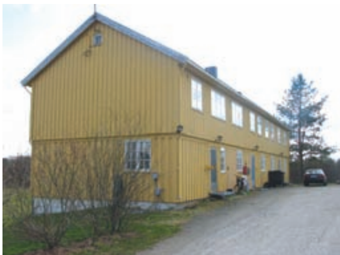
Foto: Line Bårdseng
