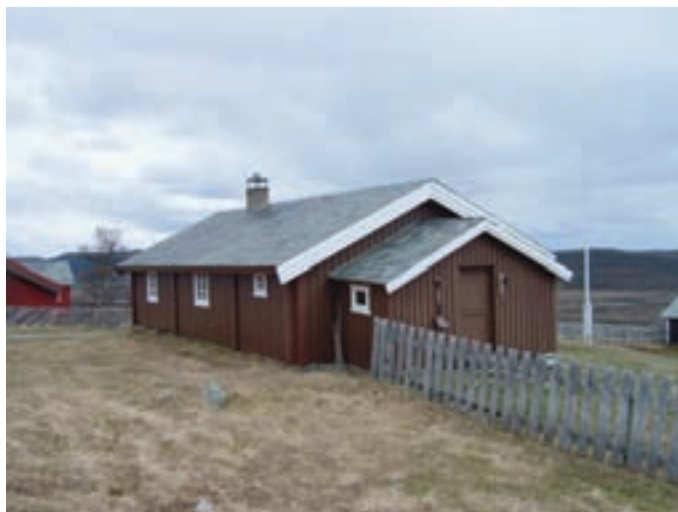
Fasade nordvest Foto: Håkon Skarstad
