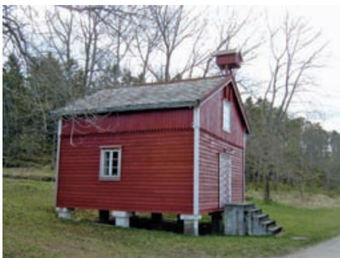
Fasade nordvest Foto: Håkon Skarstad
