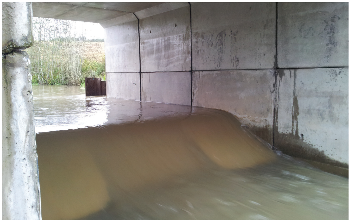
Figur 1. Vannstrømmen gjennom Crump-overløpet i Hotranelva.
