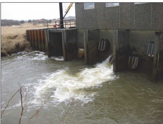
Figur 2. Utpumping av vann fra Skas-Heigre feltet. Foto Bioforsk.
