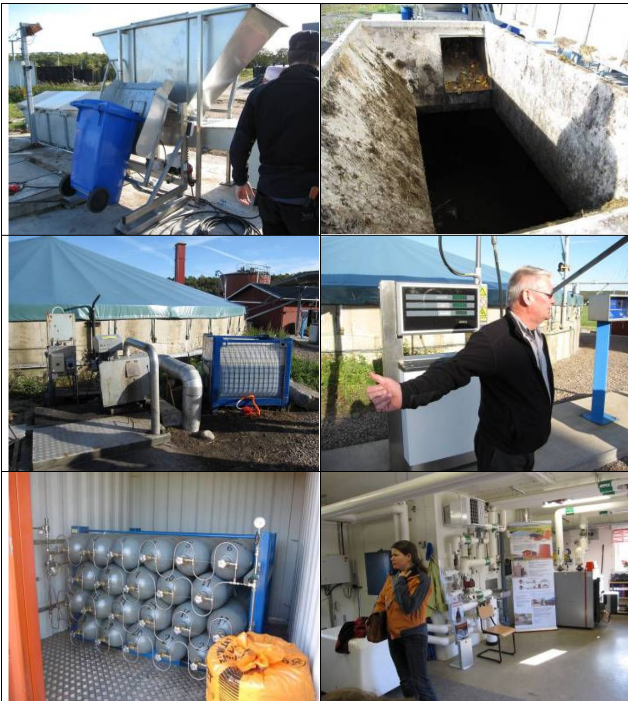
Bilder fra anlegget på Plönninge. Øverst til venstre: Blå dunker for oppsamling av frukt og kvern for finmaling, produsert av lokal smed. Øverst til høyre: Kvernet frukt går til fortank (gravd ned i bakken) og blandes med gjødsel. Midten, til venstre: I forgrunnen lokk over fortank, bak til venstre sluttlager med grønn PVC duk som dessverre ikke er gasstett. Bak til høyre rød reaktor. Plasttanken i blå ramme ved fortanken inneholder jernklorid til utfelling av svovel; skal erstattes med billigere og mindre giftig jernoksid. Midten, til høyre: Lars Hollman viser fram pumpeanlegget for oppgradert biogass, til bruk for skolens tre oppgraderte biler. Nederst til venstre: Gasslager for biogass til biler. Nederst til høyre: Liv Birkeland inne i teknikk-huset. Sterling motor under hvitt deksel rett bak Liv. Til høyre kjele for gassbrenning til oppvarming av vann. Alle foto: Kristin Sørheim.
