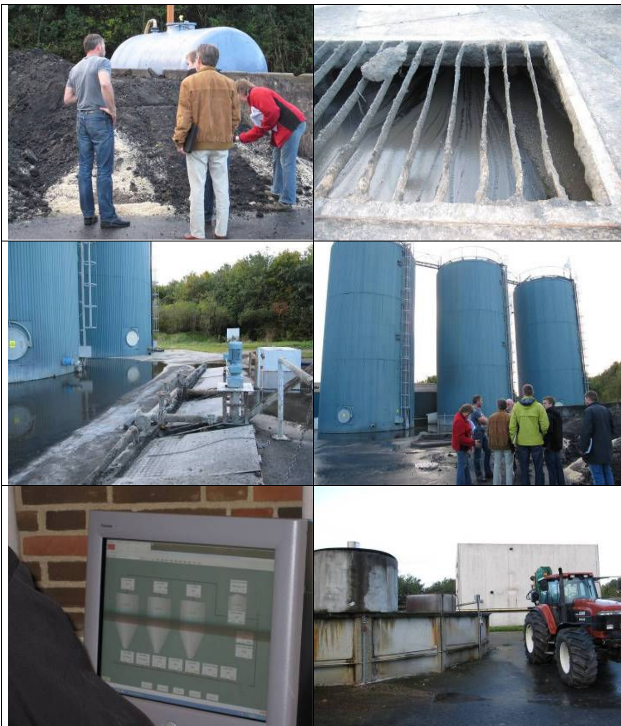
Bilder fra anlegget ved Sinding. Øverst til venstre: Plansilo med bleikejord i pulverform. Driftsleder Olav Hald til venstre. Øverst til høyre: Nærbilde av blandekum for varm, avgasset gylle og bleikejord. Risten dekker kummen, men bidrar også til å fordele bleikejorda og knuse klumper. Under ser vi blandingen av gylle og bleikejord, med en karakteristisk, grå farge. Midten, til venstre: Nærbilde av overdekke og pumper til blandekummen. Midten, til høyre: Delegasjonen samlet foran bleikejordslageret, med de tre reaktorene i anlegget i bakgrunnen. Nederst til venstre: Via et styreprogram kan man se på skjermen hva temperaturen er i hver reaktor, sammensetningen av gassen etc. Nederst til høyre: Fortank med traktordrevet omrører. Alle foto: Kristin Sørheim.
