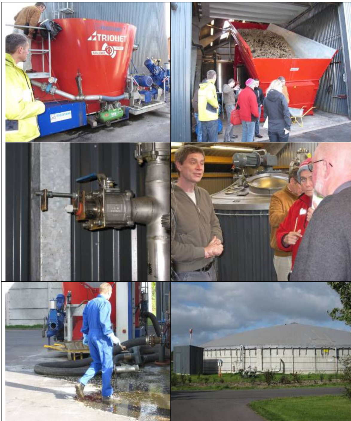
Bilder fra anlegget på Folum. Øverst til venstre: Vogelsang kvern for oppmaling av "åmateriale", talle etc. Øverst til høyre: Oppsamlingsbeholder med transportskrue for fôrrester etc. Midten, til venstre: Nærbilde av utstyr for å ta ut prøver av bioest til NIR analyse. Midten, til høyre: Alastair Ward (til venstre) foran en av forsøksreaktorene. Nederst til venstre: Dr. Henrik Møller på vei til reaktoren for å åpne stakeluka litt til, for å få fjernet et uheldig flytelag og reparert omrøreren. Nederst til høyre: Sluttlager med gasstett tak og oppsamling av restgass. Til venstre utstyr for faking ved overskuddsproduksjon av gass. Alle foto: Kristin Sørheim.
