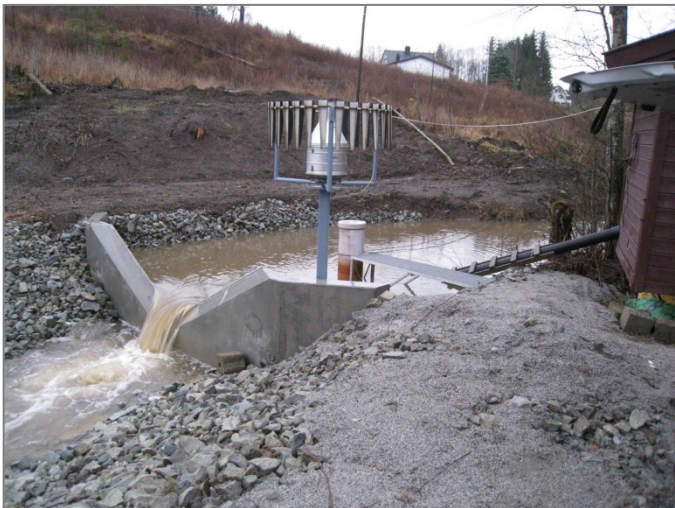
Figur 2. Den nye demningen og nytt måleprofil i Kolstadbekken. Midt i bildet ser vi nedbørmåler og til høyre målehytta. Foto: Bioforsk.
