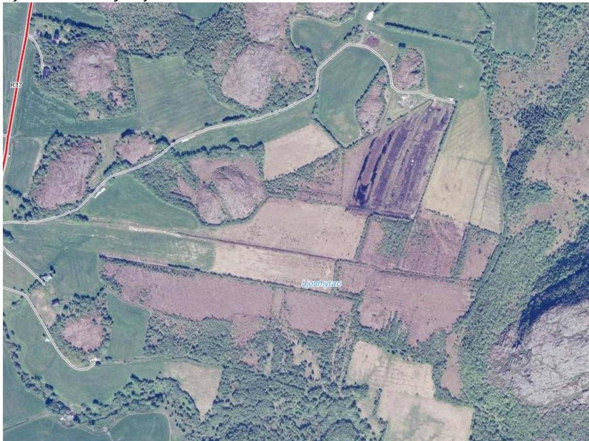
Figur 19: Ortofoto av Ljosmyran. Lokaliteten er svært fragmentert og degenerert som følge av dreneringskanalsystemet.
