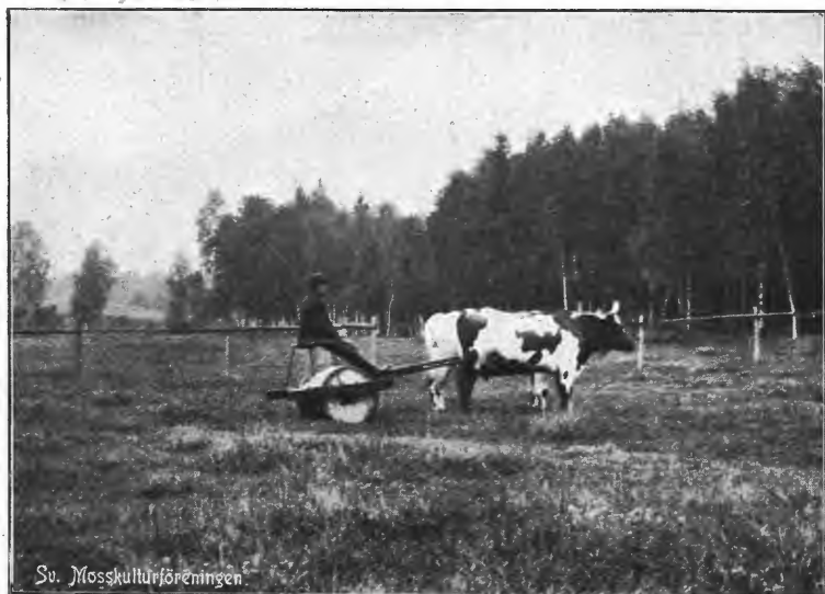
Vältning med betongvält, sedd från sidan.
