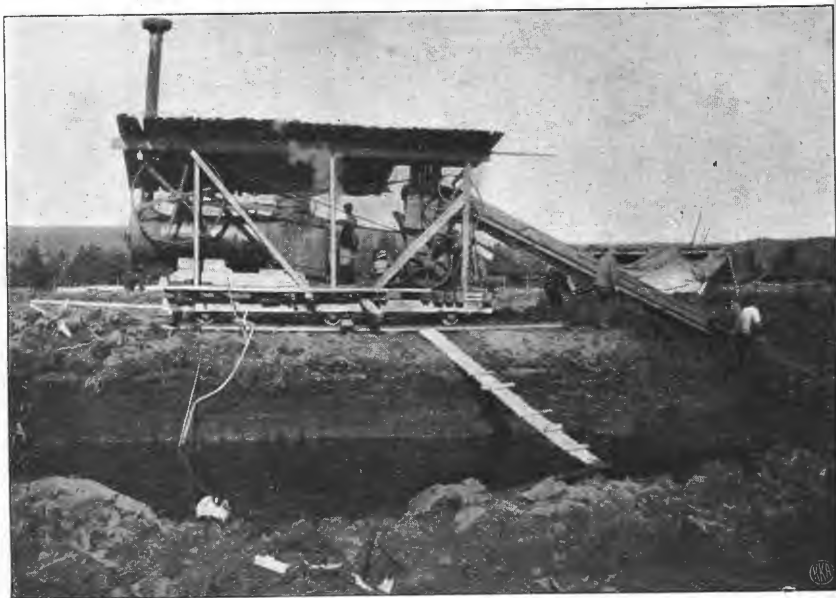
Torvmaskin i arbeide set fra siden.
