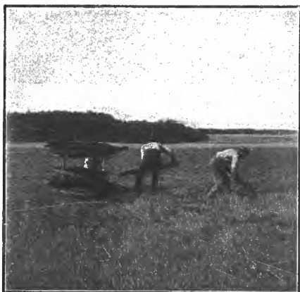
Maskintorv utlægges til tørkning.
