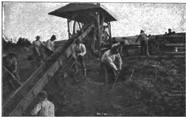
Torvmaskin i arbeide set foran elevatoren.
