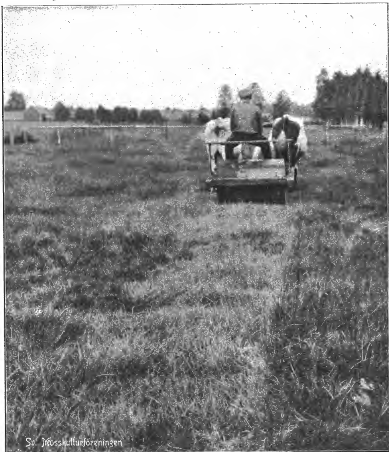
Vältning med betongvält, sedd bakifrån.
