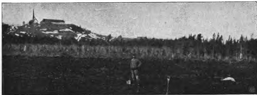
Forsøksstasjonen på Mæresmyren. Arbeidets påbegynnelse våren 1908.
