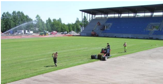
Bilde 7: Utlegging av ferdigplen fra storruller. Legg merk til vanningsanlegget på en varm sommerdag. Foto: Agnar Kvalbein
