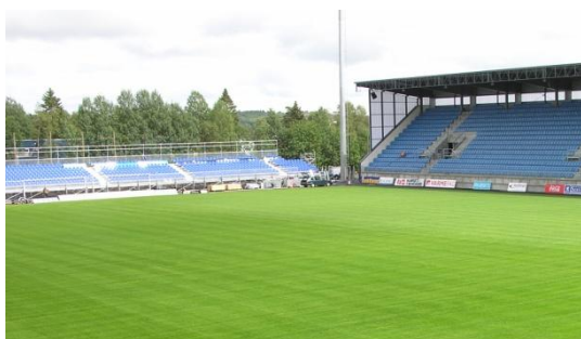
Bilde 17: Komplett.no arena i Sandefjord har åpne hjørner. Dette gir bedre vekstforhold for gresset. Foto: Agnar Kvalbein
