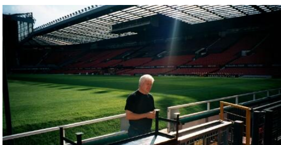
Bilde 16: Selv med glasstak, som her på Old Trafford, er skyggene av tribuneanlegget en stor utfordring. Gressmatta på denne banen skiftes derfor hvert år. Foto: Agnar Kvalbein
