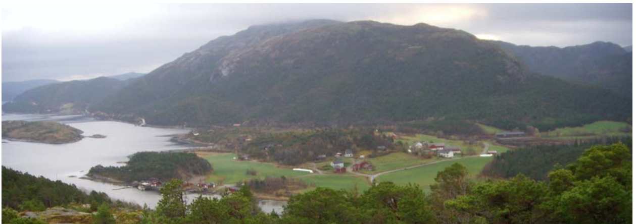
Bilde 1. Bygninger og dyrkamark er eksempel på tekniske inngrep som fører til direkte arealtap for reindriften på Otterøya
