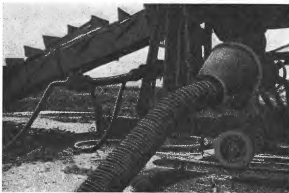
Tilkobling av utførselsledning.
