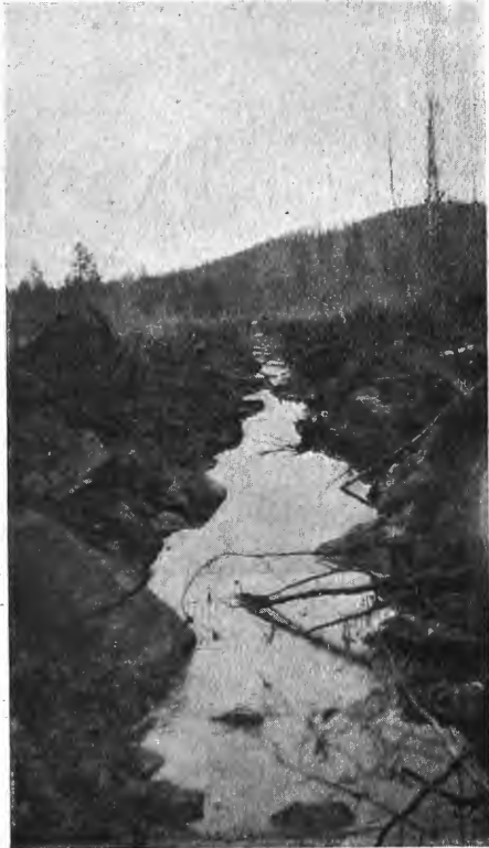
Grøft opskutt med en rekke 100 gr. ladninger.
