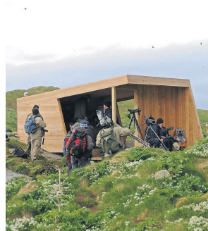
TILRETTELACT: Biotope har gjort en stor jobb for å gjøre Hornøya mer besøksvennlig for fuglekikkere. Dette skjulet er et av tiltakene.
