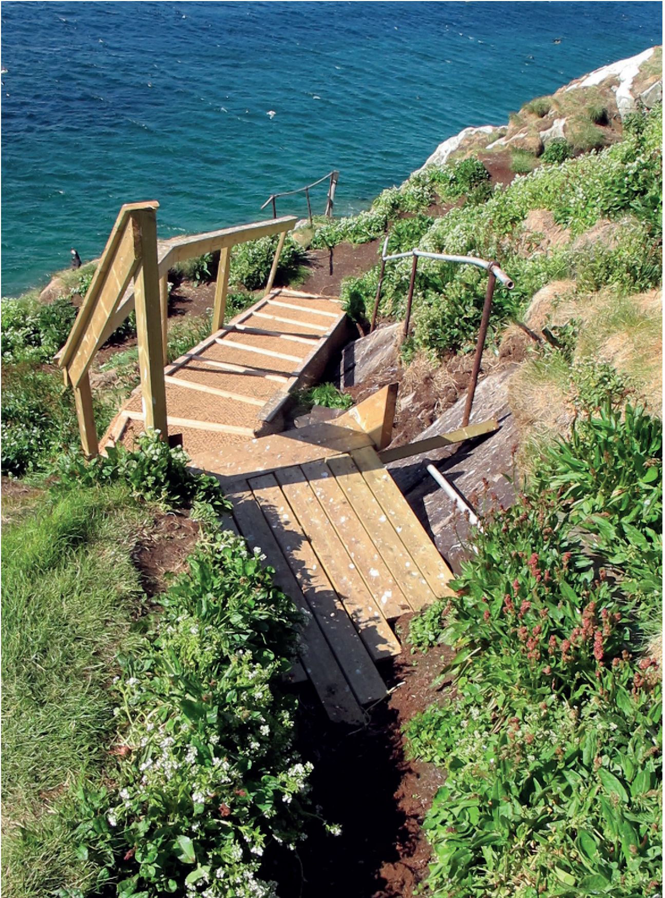
Trappa belagt med kokosmatte og platting i trykkimpregnert over trappa ettersom det kan være våt jord. Foto: SNO
