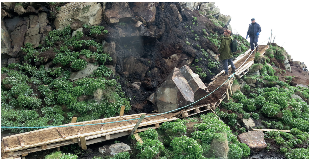
Steinspranget sommeren 2017 stoppet ferdsel langs stien. Stien må sannsynligvis legges om og det er usikkert når en kan få gjort dette. Foto: Statens naturoppsyn (SNO)
