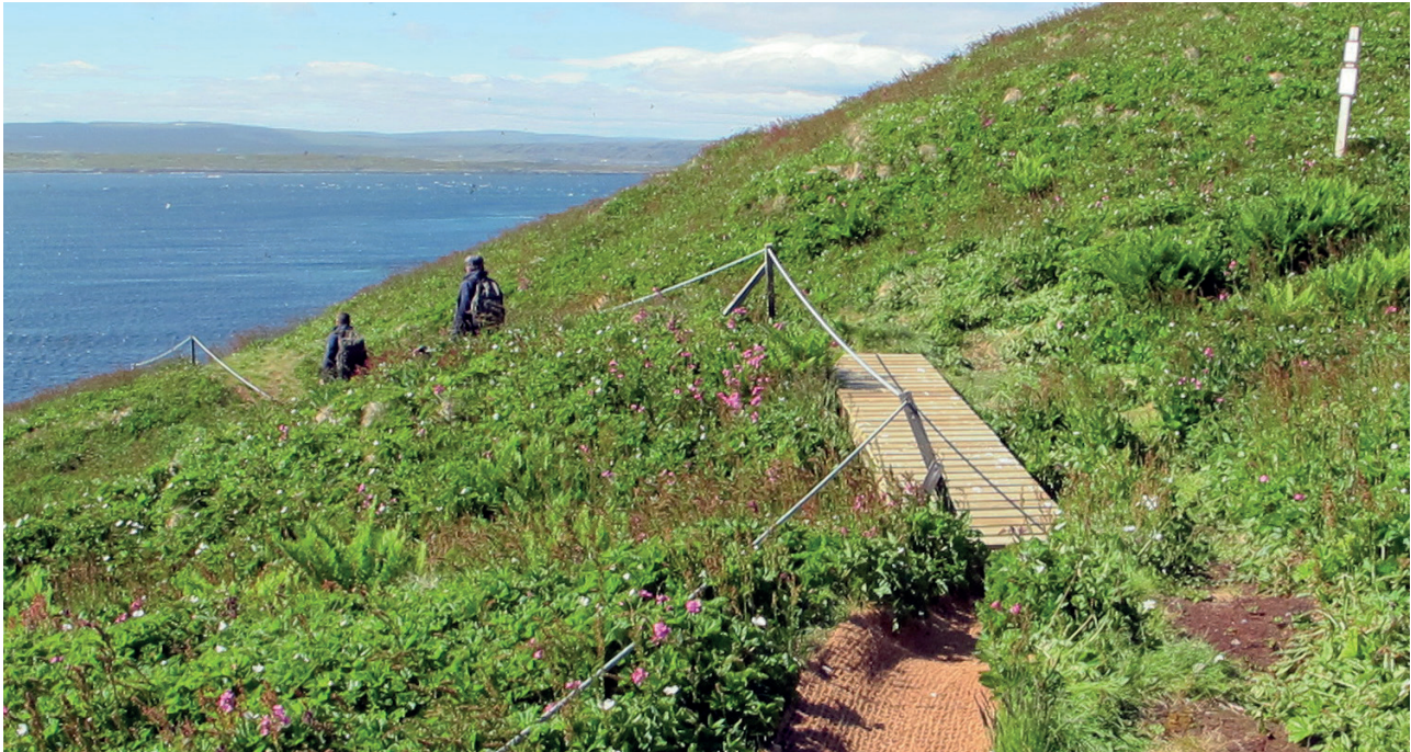
Sammen med SNO og på oppdrag fra SNO både bygger og vedlikeholder Vardø havn KF stien og trapper. Bildet viser kokosmatte lagt inn i stien og en klopp i planker over et spesielt fuktig område. Foto: SNO
