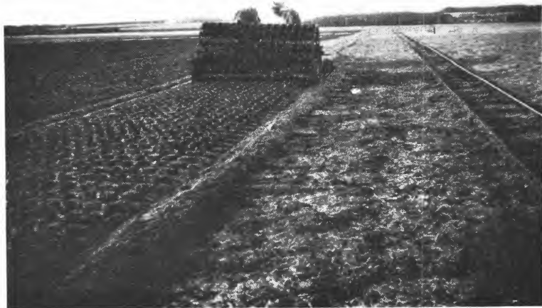
Fig. 4. Fra Kultørvefabrikken Blaahøj, Danmark. Torvmassen jevnes utover tørkeplassen og formes.
