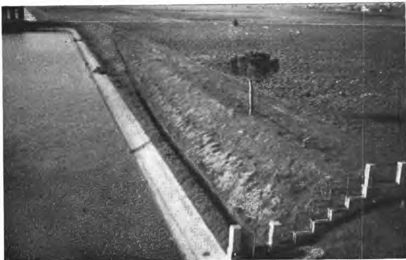
Fra Il Masocchio pumpestasjon ved kanal Della Selcella. Terrengnet ligger her ca. \frac{1}{2} m under havflaten, mens vannstanden i kanalen holdes ca. 2 m under sjøvannstanden, dvs. 1\frac{1}{2} m under terrengnet.
