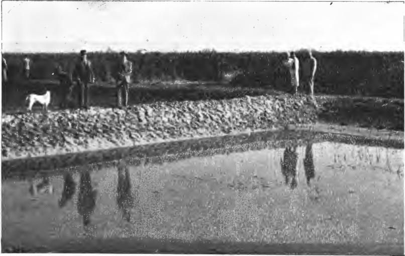
Fra Mezzano-distriktet. Her ser vi en «supleringskanal» som leder slamrikt vann fra Lamoneelven utover elvebreddene. I bakgrunnen kraftig vegetasjon av takrøyr.
