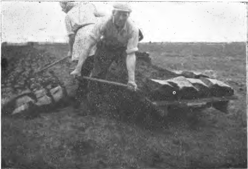
Fig. 1. Fra Knudmose ved Herning. Torva legges ut fra traller og deles opp.
