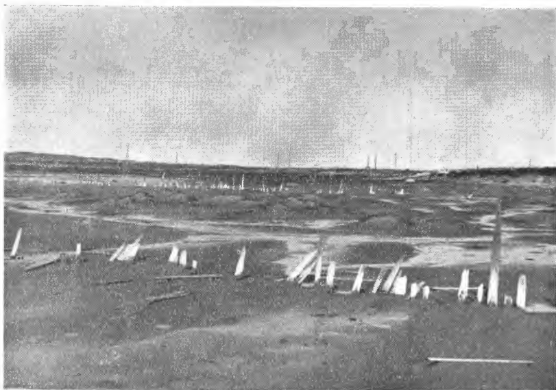
Fra det uttappede Orrevann på Jæren. Sandflukten søkes hindret ved bygging av gjerder. (Fot. G. H., 1920).
