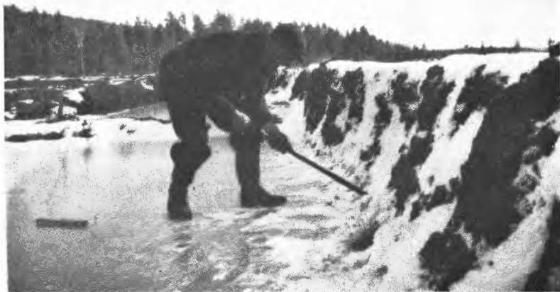
Fig. 4. Ladingen foretas. Patronene settes inn på skrå ned fra iskanten.
