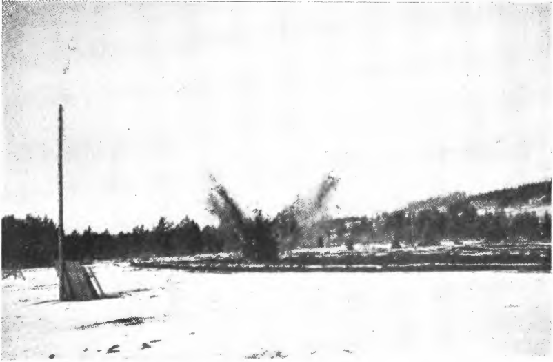
Fig. 5. Torvpall under sprengning, massen kastes opp og ut til sidene.
