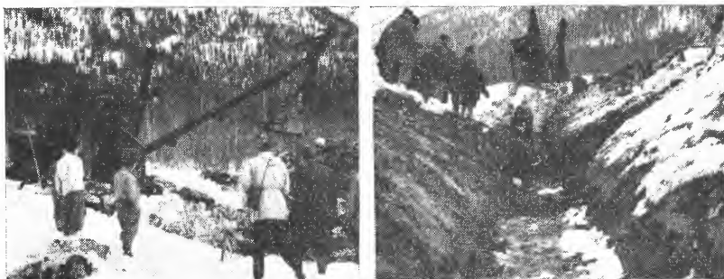
Fig. 2. Stor gravemaskin i arbeid med kanalisering på frossen myr, Brydalen, Tynset.
