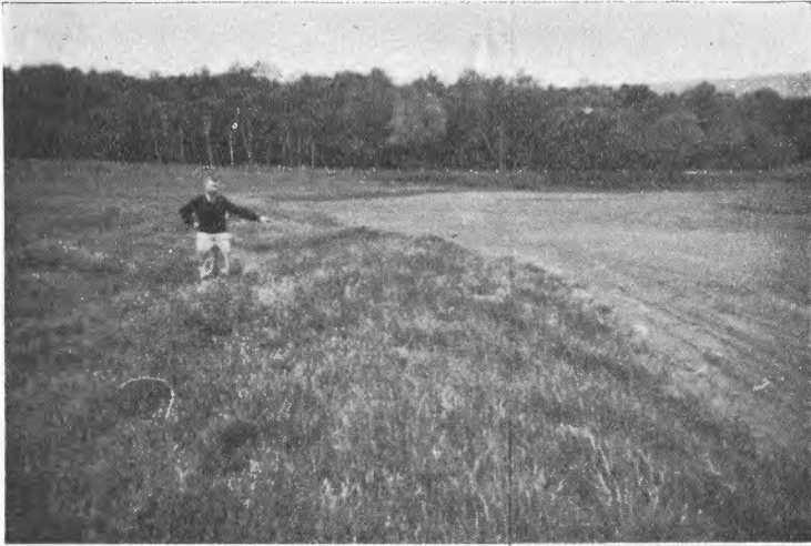
Fra Gate Hill Garden farm, Hampshire County, Massachusetts. Jorderosjonen er stoppet ved avledningsgrøfter og terrassering. (18/5—51).
