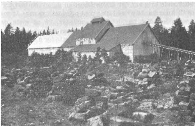
Torvstrøfabrikk av standardtype, middels størrelse. (Fot. Aa. L.)
