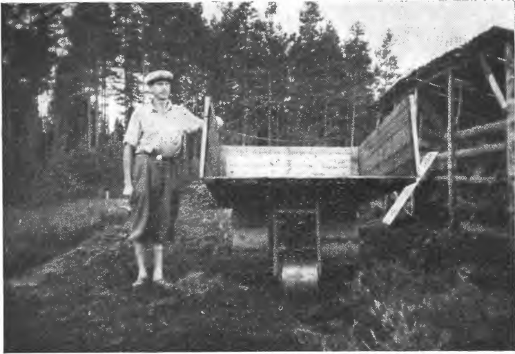
Fig. 4. Bildet viser transportvogna etter at den er utstyrt med stålplatehjul i stedet for gummihjul. (Fot.: Aa. L.)
