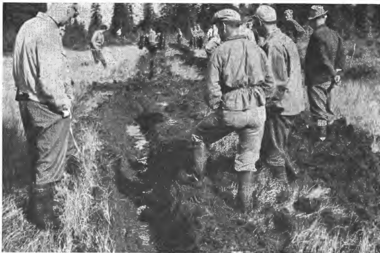
Fra demonstrasjonen på Store Råssumsetermyra i Brandbu almenning. Grøftefreseren har nettopp passert et meget vått myrparti hvor grøften delvis ség igjen, men ved tilbakekjøringen ble det grøft også her.
