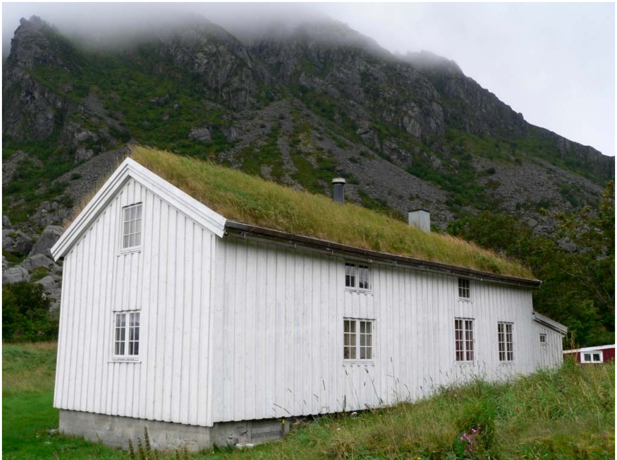
Bilde 3: Hovedhuset på nordvestsida er satt i stand som fritidsbolig. Foto: T. H. Carlsen
