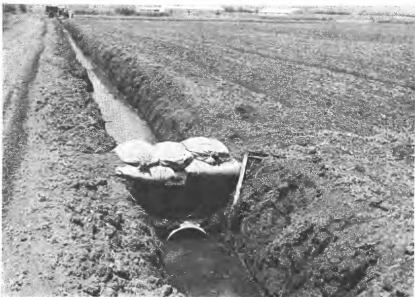
Fra Hula myrene. «Fordelingsgrøft» med klopp av sandsekker. På bildet sees to gjennomløp som begge benyttes ved regulering av vannhøyden i torpedogrøftene. Fot. Aa. L.
