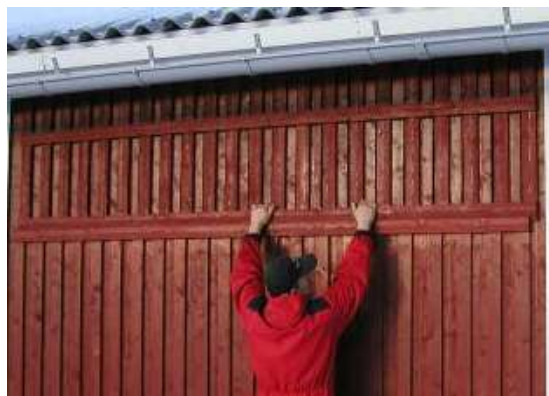
Figur 1. Sprekkpanel med regulerbar åpning
