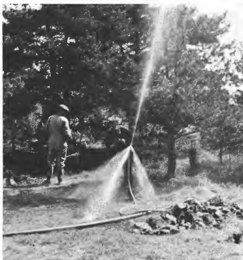
Fig. 2. Selve spyleorganet har en stråle rettet forover og tre stråler på skrå bakover. Trykket i slangen er opptil 65 atmosfærer.
