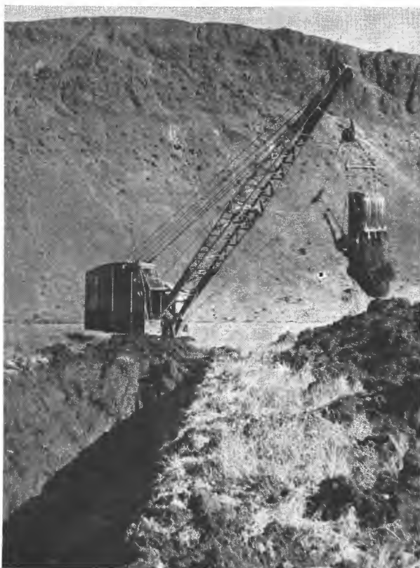
Fig. 3. Gravemaskin av slepe-skovltype i arbeid på Sør-Island.
