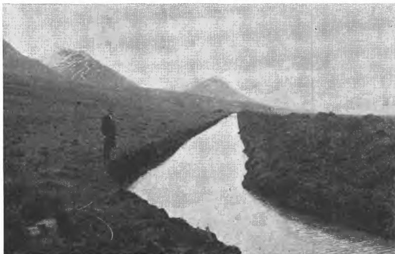
Fig. 2. Kanal gjennom et sumpaktig myrområde på Nord-Island, gravet 1942—1943.
