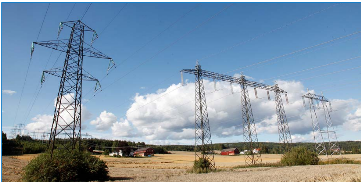
Bilde 33. Fra bakkenivå vil mastene til store overføringslinjer ruve i lavlandsbygdene åpne landskap, mens de raskere kan skjules i skogsbygdene mindre og mer lukkede landskapsrom. Fra Øvre Eiker kommune.
