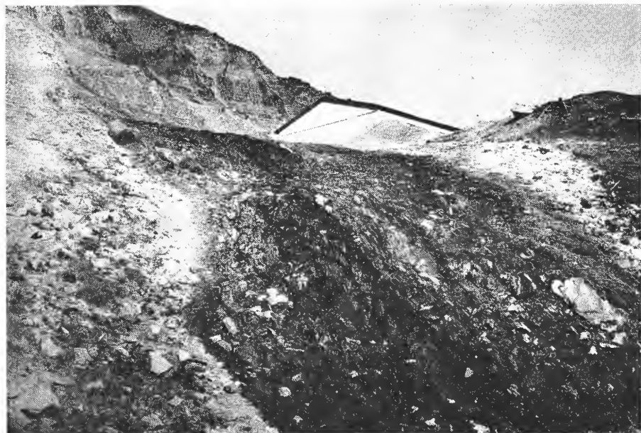
Fig. 2. Den mørkfargete bratte skråningen i forgrunnen mangler høyere vegetasjon på grunn av dannelse av sur sulfatjord. 12.7. 80.
