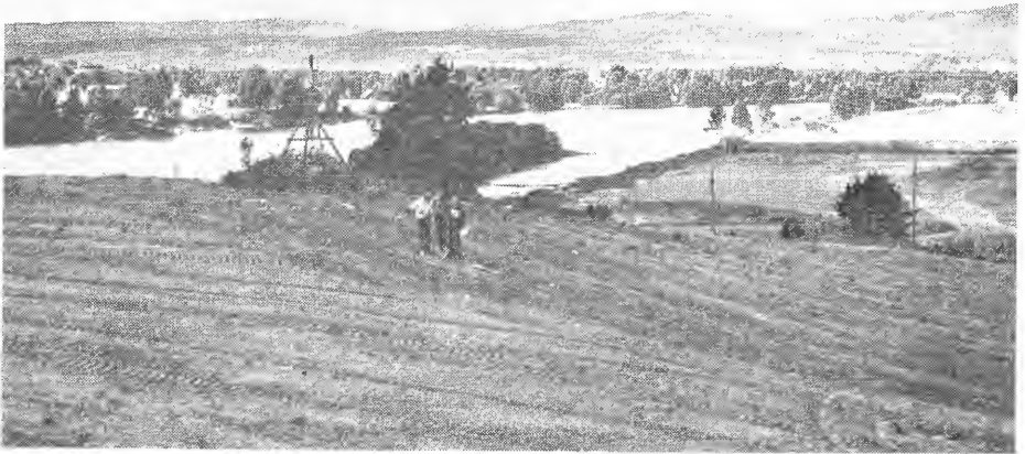
Fig. 3. Ferdig påfylt og planert areal i forgrunnen. Mot elva er det påbegynt oppfylling for å omdanne et tidligere ofte oversvømt sumpmarkområde til jordbruksareal. 27.VIII.81.
