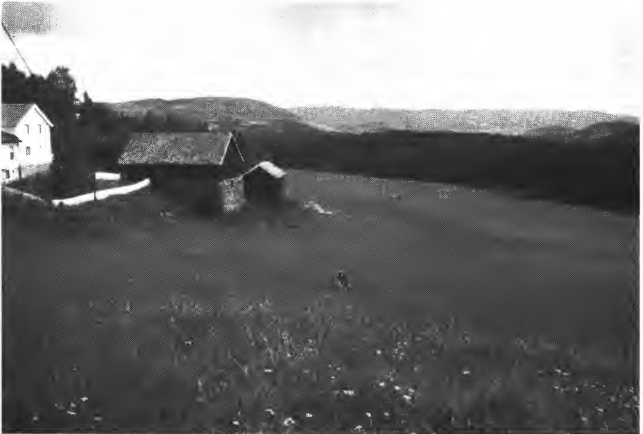
Bilde 4. Etter avsluttet arbeid i 1985. Over sprengsteinen er det lagt 30-50 cm jord.
