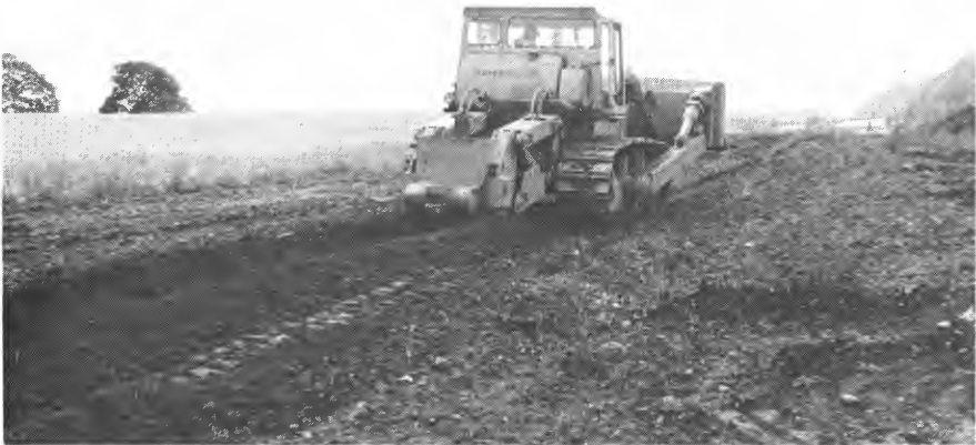
Dyp grubbing av topp-laget over avfallsfylling i Bærum, kjørt med 2 m's avstand. Dermed «åpnet» en hardpakka masser.
