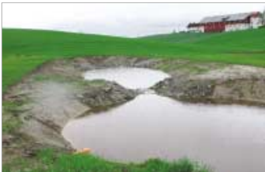
På Åstorp er nedre del av bekken utformet som dammer, blant annet for å øke renseeffekt og flomdemping. Mellom dammene er det bygget en erosjonssikret terskel. Foto: A. Hauge
