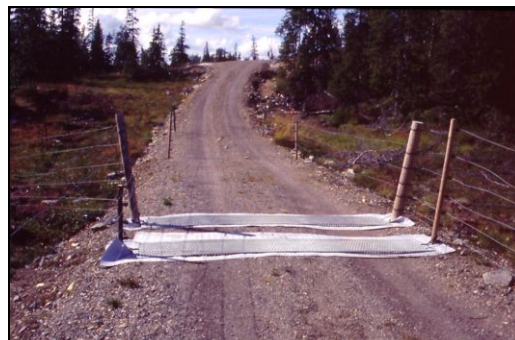
Elektrisk ferist bestående av to strømførende plater (foto: R. Bjøru). An electric cattle crating consisting of two electric boards.
