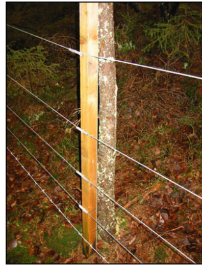
Fire-tråds strekkgjerde med underliggende piggråd. Merk isolatorfestet til treet (foto: I. Hansen). A four wire electric fence with barbed wire at bottom.
