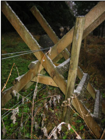
Gjerdekliv, ikke av anbefalt type. Merkelig trådføring og mye vegetasjon (foto: I. Hansen). Steps for entering the fence, not of recommended type.
