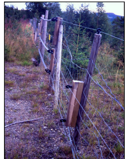
Variert av utbedret sauegjerde med topptråd og to strømførende tråder på utsiden (foto: R. Bjøru). A sheep net supplied with three electric wires.
