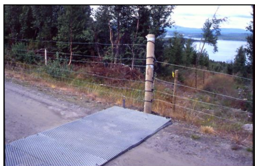
Elektrisk ferist bestående av ei brei strømførende plate (foto: R. Bjøru). An electric cattle crating consisting of one electric board.
