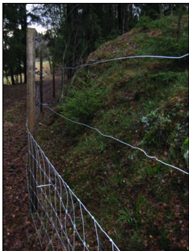
Utbedret sauegjerde ved utenforliggende fjellknaus. Ekstra topptråder er montert (foto: I. Hansen). Sheep net supplied with extra wires where heights are close to the fence (here: rocky terrain).
