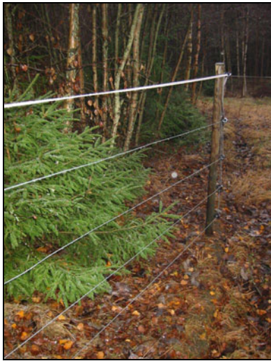
Fem-tråds strekkgjerde med hvit markering på øverste tråd (foto: I. Hansen). An electric fence with five wires, upper wire marked white.
