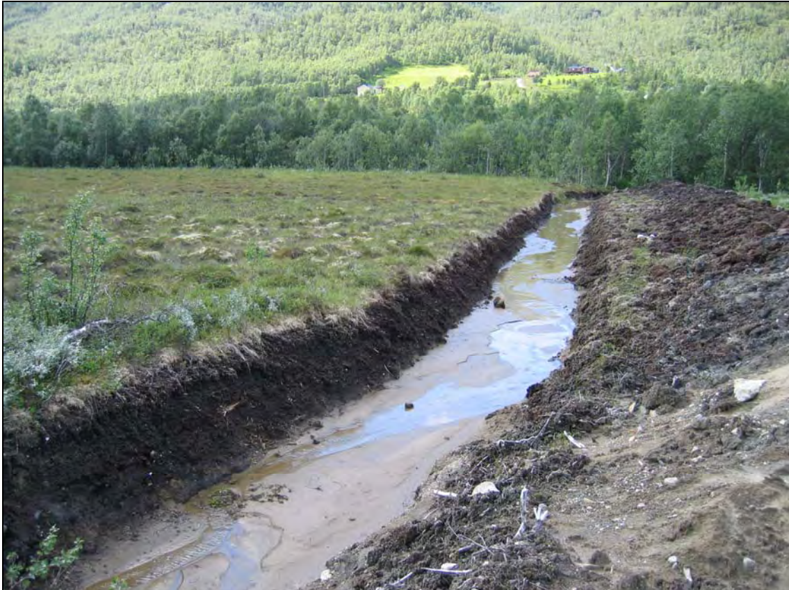
Drenering av vann i torvmyr i Kjeldebotn. Foto: ANB
