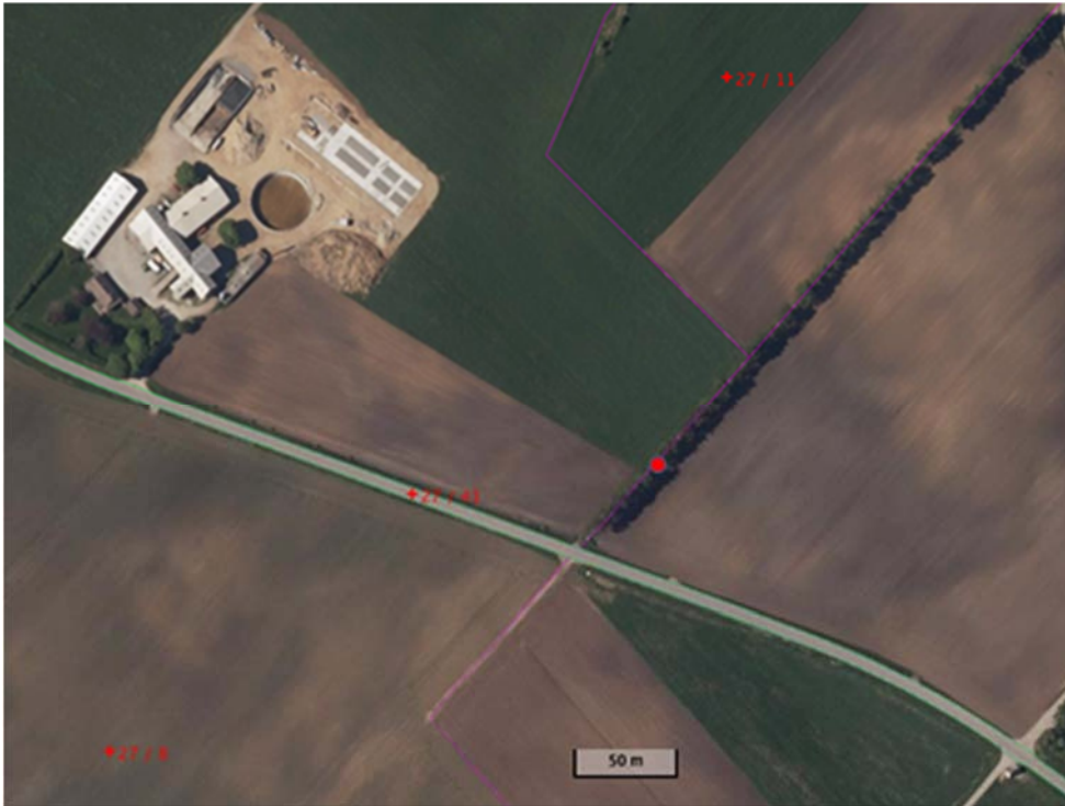
Figur 19. Flyfoto som viser beliggenhet av etablert overvåkingsbrønn for grunnvann på Horpestad i Klepp.
