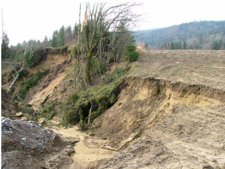
Figur 16. Ras i en ustabil ravineskråning på Rimstadmoen
