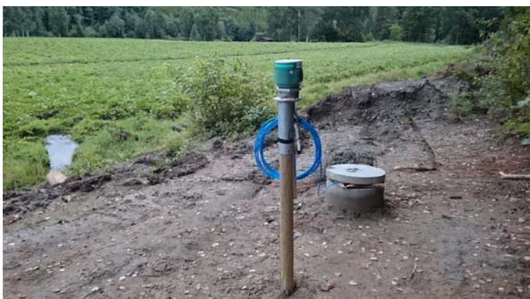
Figur 17. Grunnvannsbrønn beskyttet av kum og datalogger montert på staur på Rimstadmoen.
