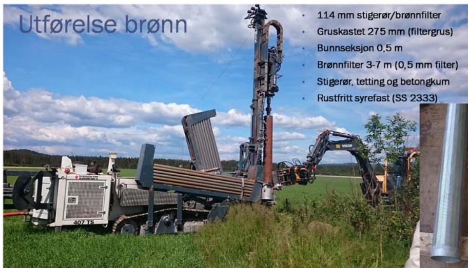
Figur 7. Etablering av ny brønn for overvåking på Haslemoen i Våler kommune.
