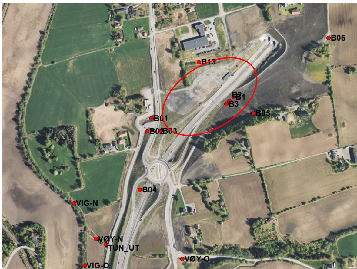
Figur 1. Oversikt over prøvelokaliteter sør for Grantunnelen. I tillegg til VIG-O og VIG-N er det et tredje prøvepunkt i Vigga (VIG-B) rett nord for bildet. Omtrentlig plassering av masselager er vist.
