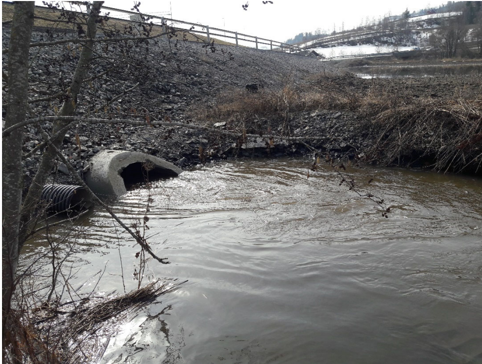
Figur 23. Utløpet av Vøyenbekken under flommen 20.04.2018. Vøyenbekken går i betongrøret, mens utløpet for drensvann fra veg og tunnel kommer ut under vannoverflaten til venstre i bildet.
