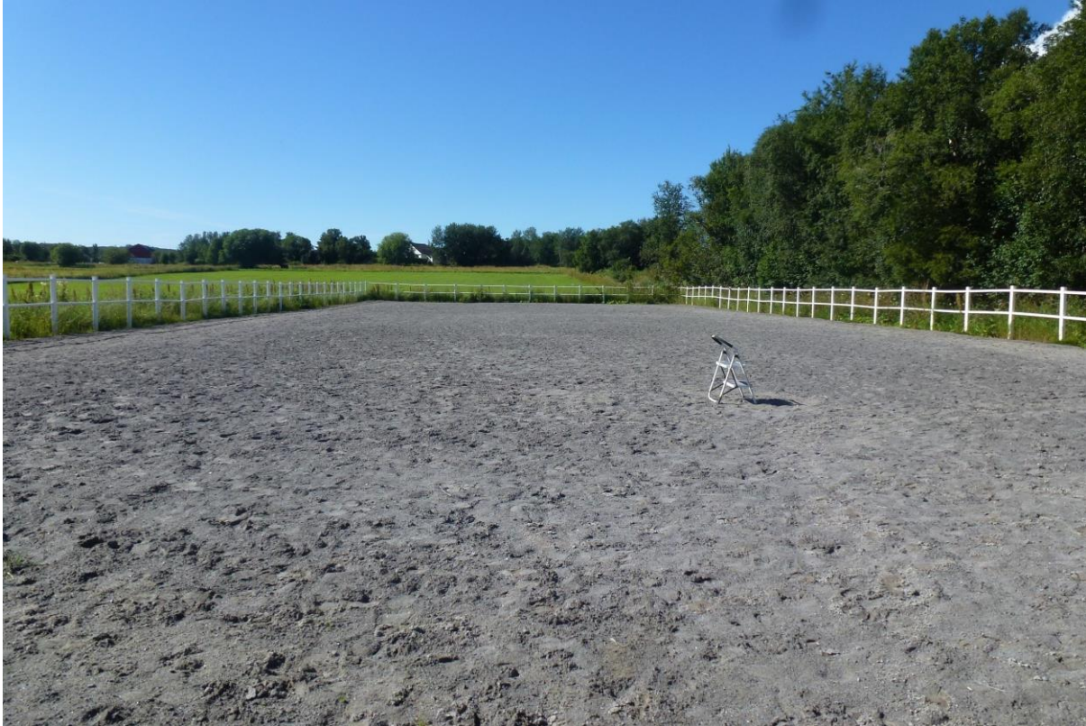
Figur 27. Ridebane på tidligere fulldyrka jord som er opparbeidet med grus. Slike areal klassifiseres som åpen fastmark , med grunnforhold konstruert . (Bodø)
