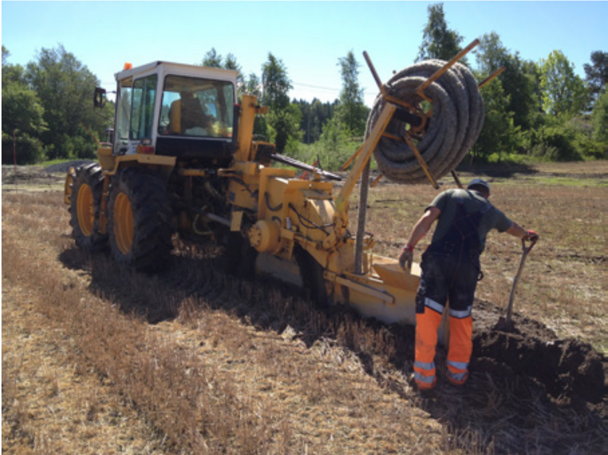
Grøfting med Rådahlshjul. Grøfting under gode, tørre forhold gir best resultat. Foto: Atle Hauge
